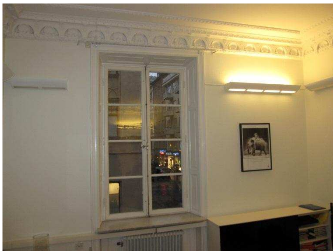
Rum i gathuset med exempel på bevarat listverk i stuck (detalj nedan). Panelade smygar och profilerade fönsteromfattningar finns i flertalet fönsteröppningar.
