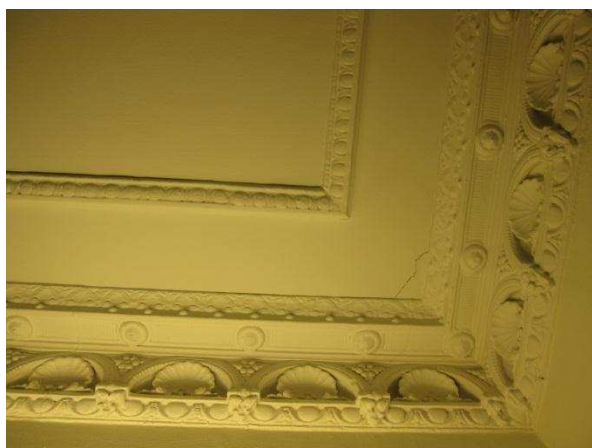
Rum i gathuset med exempel på bevarat listverk i stuck (detalj nedan). Panelade smygar och profilerade fönsteromfattningar finns i flertalet fönsteröppningar.
