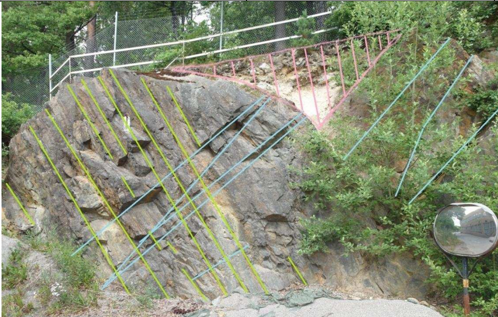
Figur 3. Västra bergskärningen. Foliationssprickor (grönt), medelbranta sprickplan (blått) och jorderosion (rosa).
