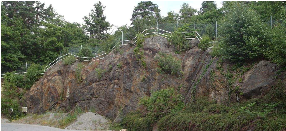
Figur 10. Norra bergskärningen. Bergblock ligger på grushög nedanför bergskränigen.
