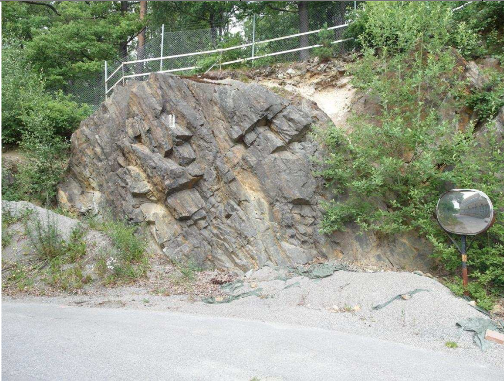
Figur 9. Västra bergskärning. Jorderosion syns tydligt i övre högra hörnet av bilden.
