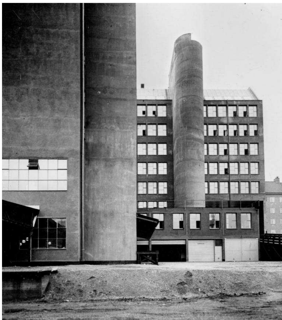
Foto av magasinets gavel och insidan på gathuset, som tydligt visar betongfasaderna med synliga gjutskarvar och spår av formbräddor. De kraftfulla tornkropparna innehöll hiss (magasinet) respektive trappa (gathuset).
