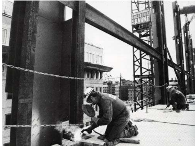
Byggnadsarbeten vid uppförandet av Trollhättan 33. Byggnadsfirma var Ohlsson & Skarne. Källa: Arkitekter bygger i stål 1980
