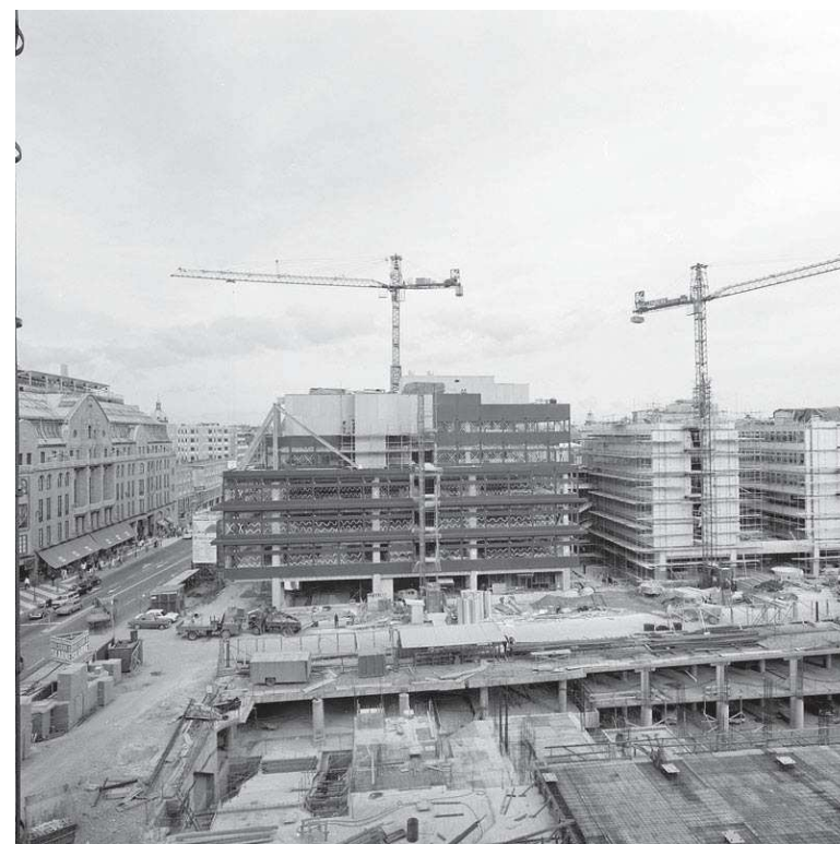
Foto från ca 1974-75. Närmast i bild syns pågår bygget av kvarteret Trollhättans två nedersta planen under mark som bland annat innehåller garage och spärrhall till tunnelbanan. Kvarteret Spektern är under uppförande på andra sidan Regeringsgatan. Till vänster syns Nordiska Kompaniets byggnad vid Hamngatan. Fotografen är Lennart af Petersens. Källa: Stockholms stadsmuseum.
