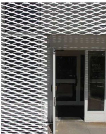
Ovan: stormaskig sträckmetall i bronseloxerad aluminium kan användas t.ex. på på länkdalar och räcken. Varm färgton och metallisk glans kontrasterar fint mot de matta, betongliknande fasadskivorna.
