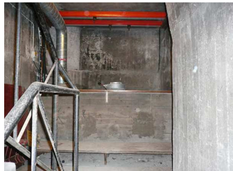
Högst upp i slangtornet finns hänganordningar och trästeg bevarade för uppvinshning av tvättade slangar för tork. Numera är slangtornets schakt igenbyggt för ny ventilation.
