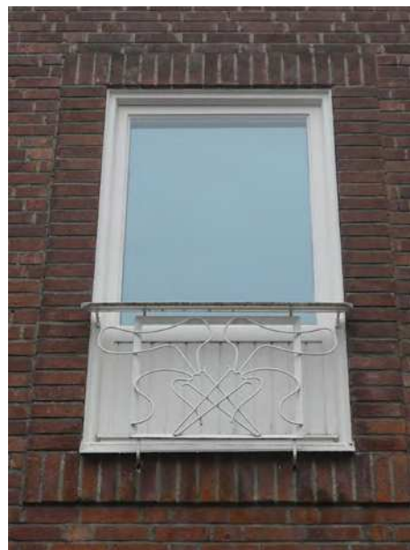
En dekorativ detalj på vagnhallens sydöstra gavel med franskt fönster, mönstermurad omfattning och smide i form av två facklor.
