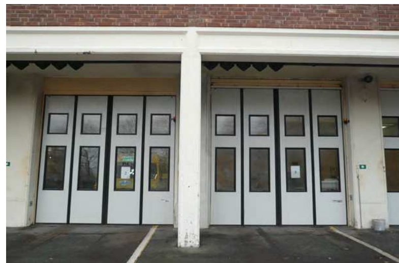
Stationen byggdes under kriget och för att klara en krigssituation uppfördes starka betongpelare och betongbalkar runt portarna. Den bevarade hänganordningen över portarna är till för extra stålportar som skulle kunna stå emot tryckvågor.
