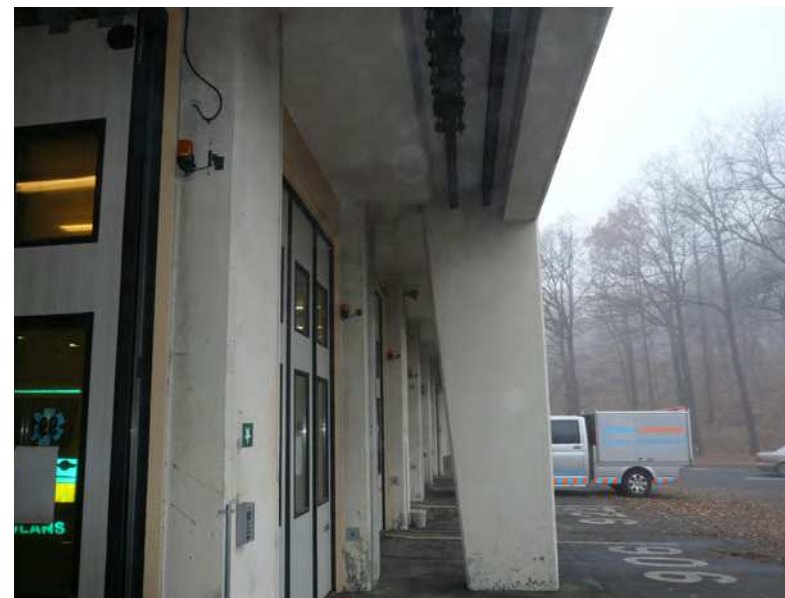
Unik är konstruktionen med bl.a. starka betongpelare och balkar samt särskild upphängning för portar som skulle klara tryckvågor - en spegling av att stationen byggdes under andra världskriget.
