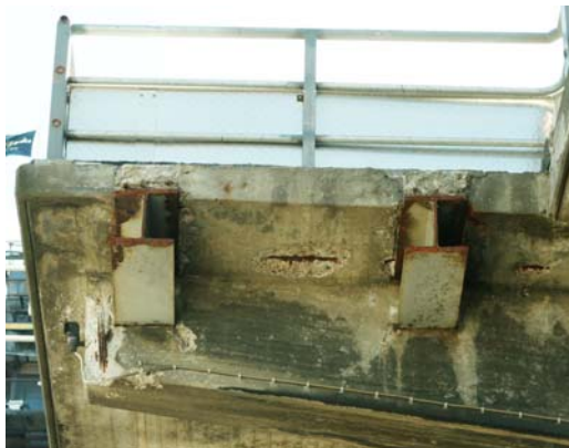
Bild 2.2 Skadad betong ovanför Stadsgårdsleden.
