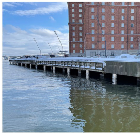
Kaj på pelare vid Saltsjövarn med kajskoning av ett raster i trä.
