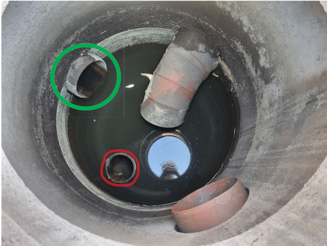
Figur 4-5 visar mätpunkten under torrperiod. Det går att se dykarledningen markerat i rött som är en utgående ledning. Det går också att se bräddledningen högst upp i bild. Ledningen där det mättes och provtogs är markerad med grön ring.
