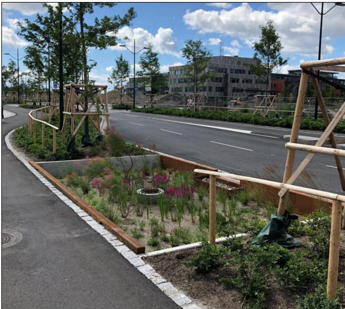
Figur 14. Nedsänkt regnbädd i Malmö med erosionsskydd vid inloppet och bräddutlopp i form av en kupolbrunn. (Foto: Norconsult)
