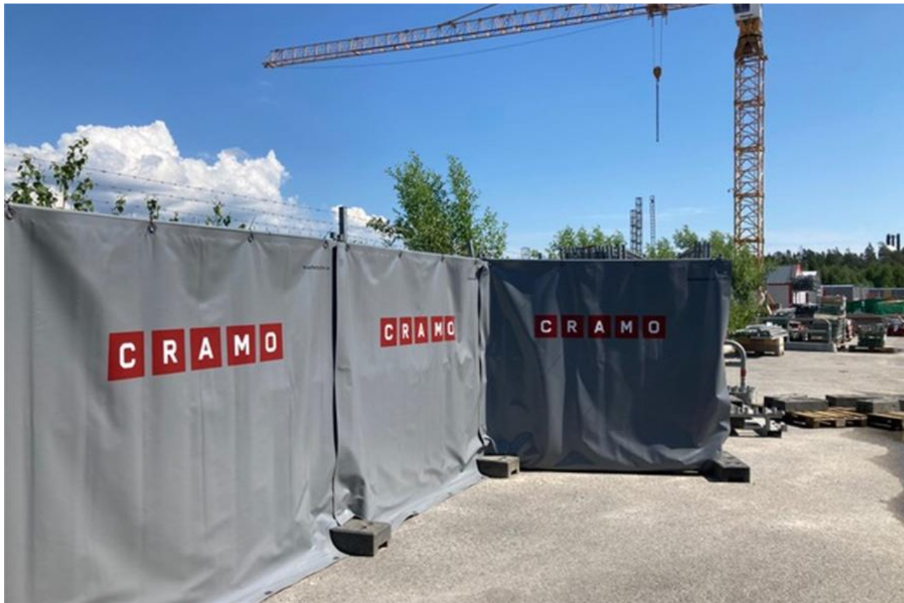
FIGUR 3. EXEMPEL PÅ TEMPORÄRT BULLERSKYDD VID ARBETSPLATS.
