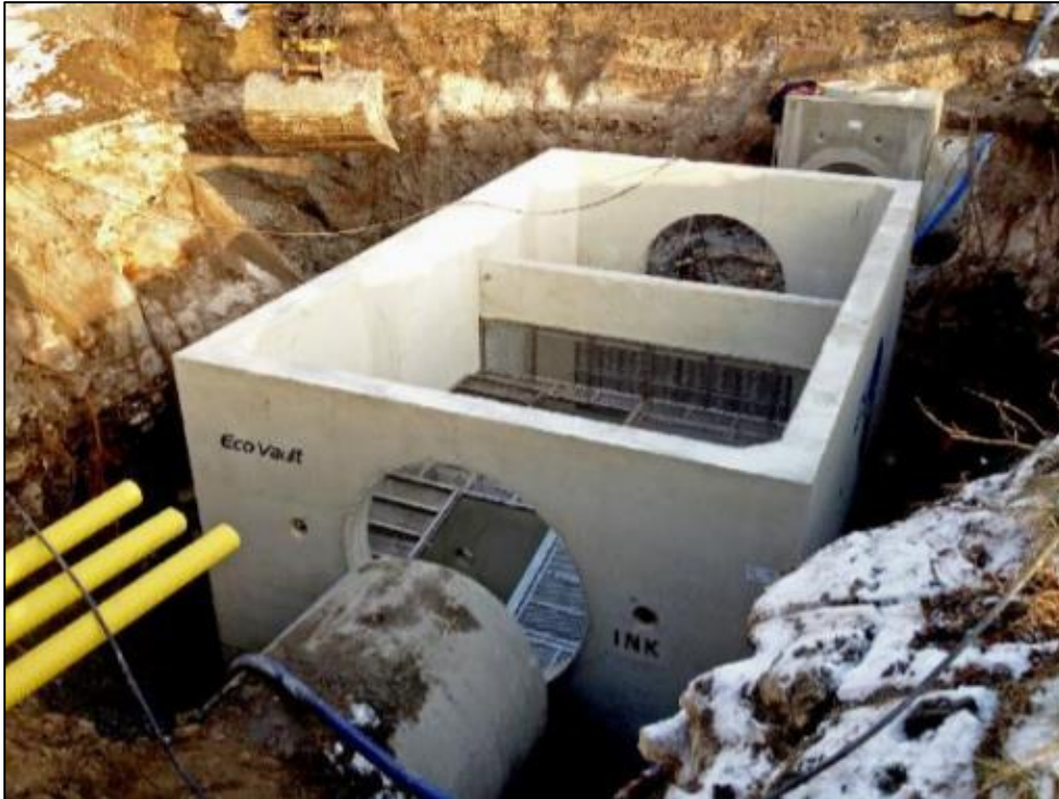
Figur 8. Exempel betongmagasin
