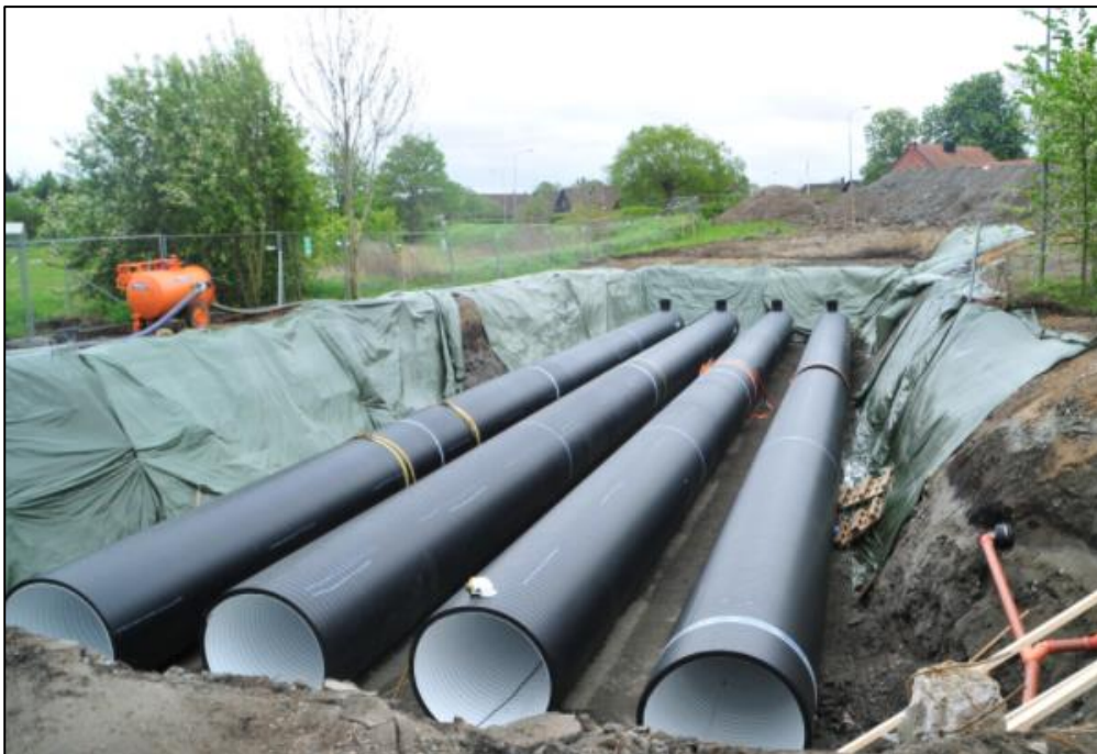
Figur 7. Exempel rörmagasin
