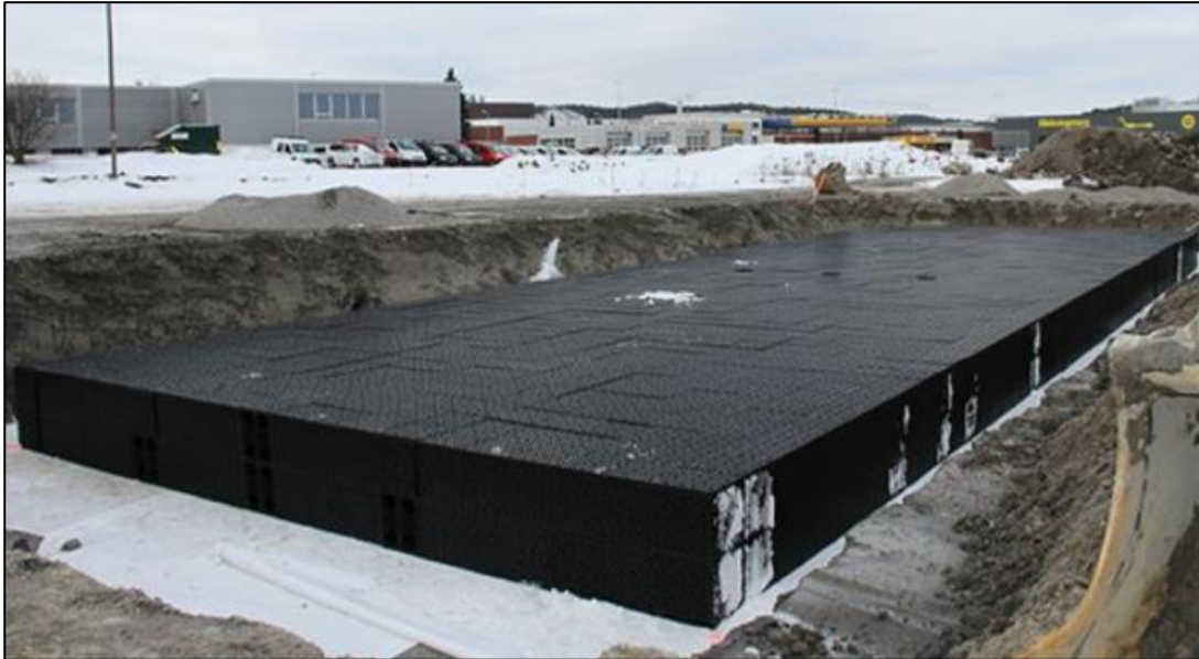
Figur 5. Exempel kassettmagasin (Rent dagvatten, 2015)
