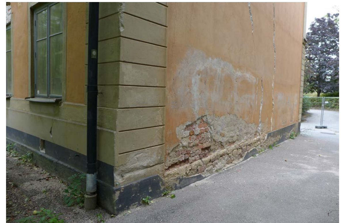
Ovan södra och östra fasaderna. Nedan del av byggnadens västra gavel där sättningskador visar sig i form av sprickor i fasaden. här syns även husets sandstenssockel.
