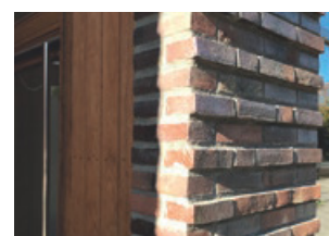
Exempel på tegeldetaljering i sockelvåningar – reliefmurning är exempel på hur detaljeringen i sockeln kan varieras (Bild: Erséus Arkitekter).
