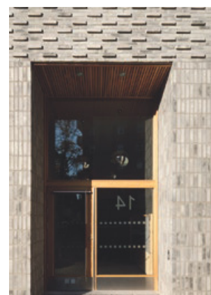
Exempel på tegeldetaljering i sockelvåningar – reliefmurning samt stapelförband ramar in och tydliggör entrén (Bild: Erséus Arkitekter).
