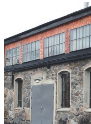
Detaljbild på Smedjan – Kraftig naturstensmur i sockel samt påbyggnadsvåning av rött tegel.
