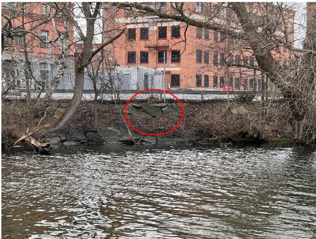
Figur 6.42. Skada i stensättningen markerad med röd ring. (Iterio, 2023)
