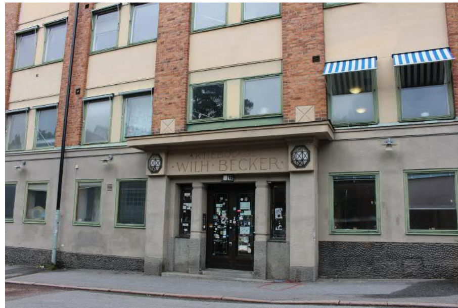
Huvudentrén mot Lövholmsgränd. Porten har en indragen placering med överstycke och utskjutande lisener i puts. Nedre delen av portalen har bearbetade granitpartier. Den ursprungliga träporten med spröjsade rutor är utbytt till en glasad aluminiumport. Ursprungliga belysningsarmaturer finns på var sida om entrén.
