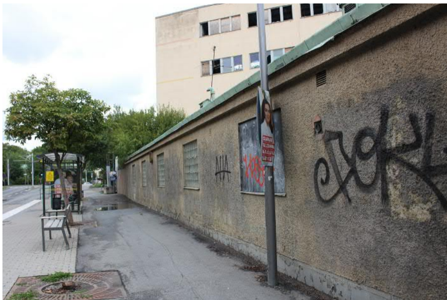
Garagets fasad mot Lövholmsvägen har spritputsats och de ursprungliga fönstren byttes ut mot glasbetong på 1960-talet när garaget gjordes om till verkstad.
