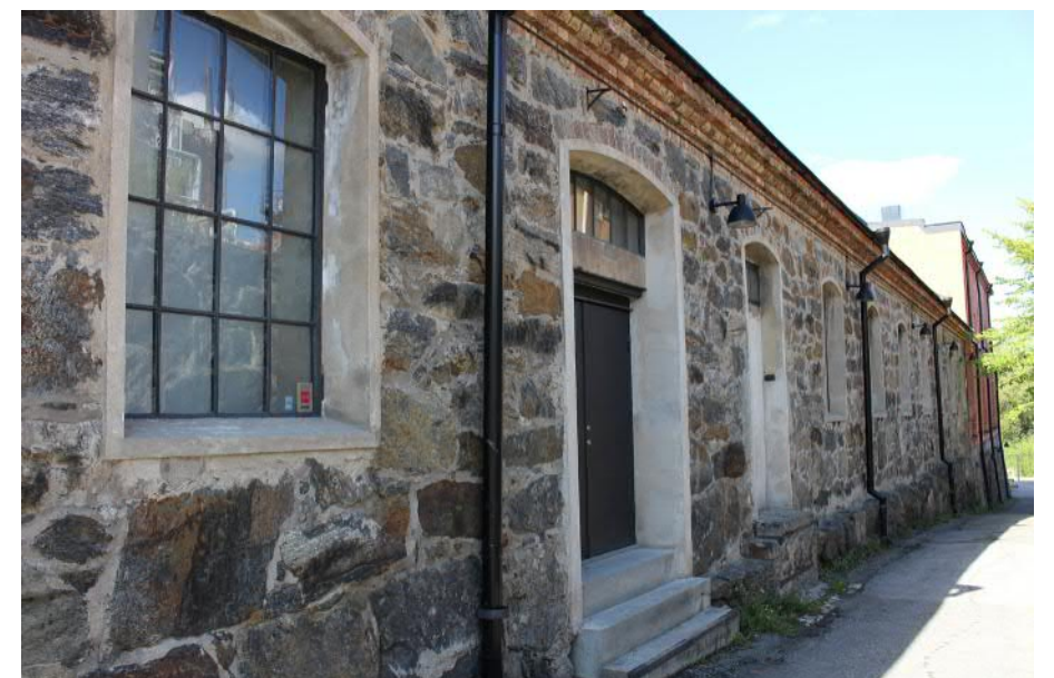
Fasad i gråsten med gjutjärnsfönster och stickvälvda fönster- och portomfattningar som förstärkts med betong.
