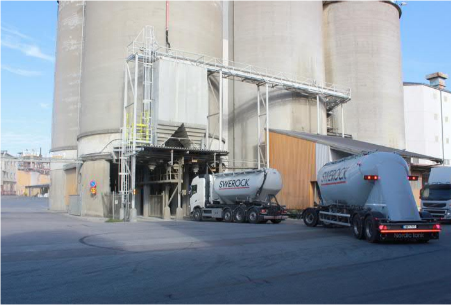
Lossningsstation för bulkbilar.
