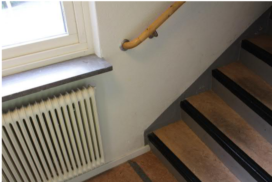
Trappa till övervåningen. Ursprungliga detaljer finns bevarade i form av radiatorer, fönsterbrädor i kalksten och trähandledare i trappa.
