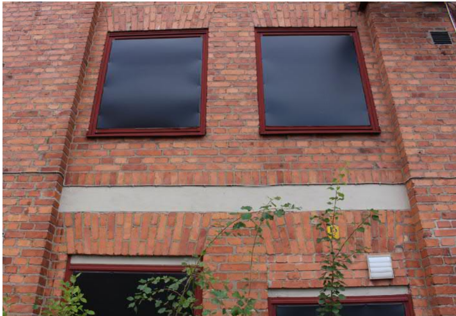
Alla fönster utom trapphusfönster har bytts ut till en- eller tvålufts-fönster med rödmålade träbågar. Fönsterbyten utfördes under 1950- och 1970-talet.
