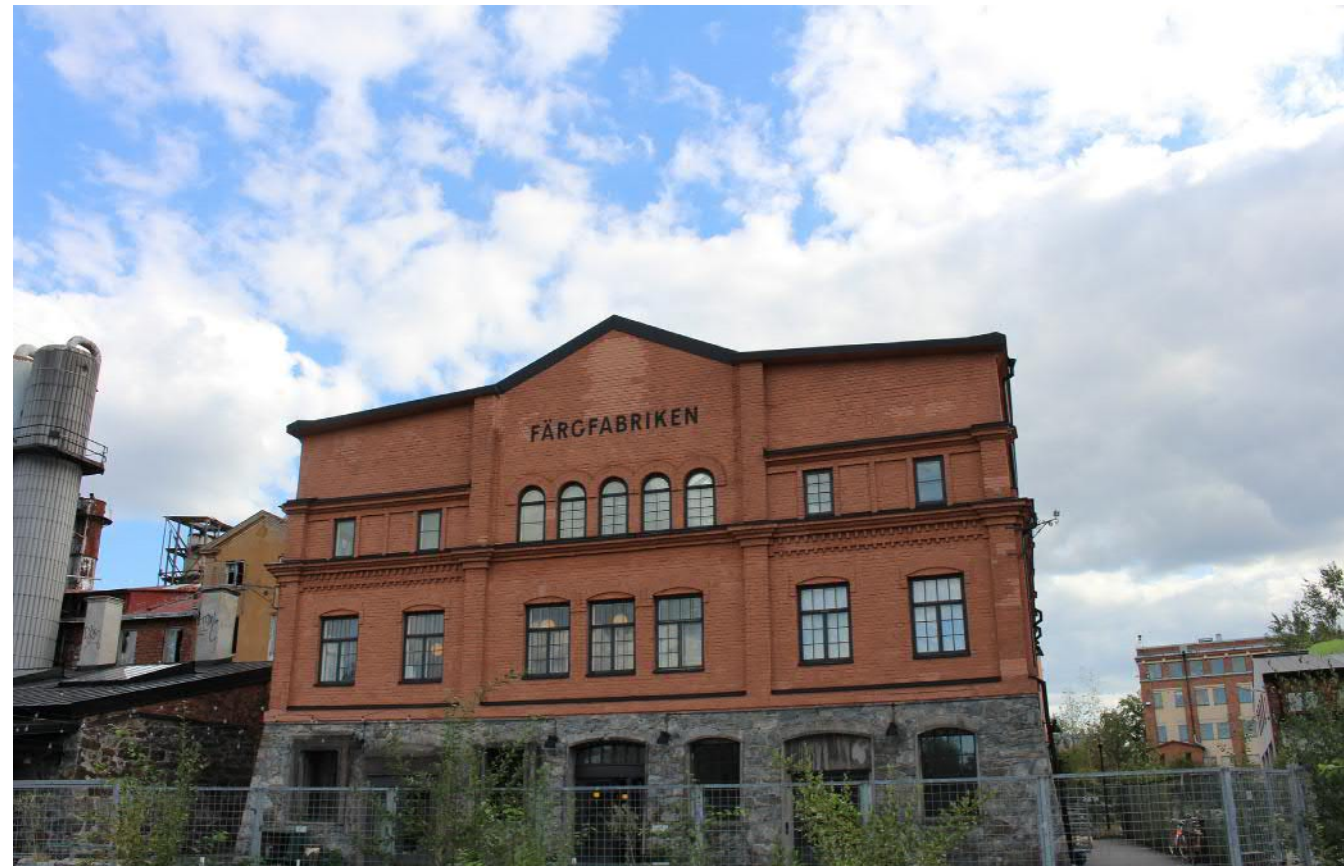
Norra gavelfasaden. Byggnaden har en kraftig naturstenssockel och slammade tegelfasader i de övre våningsplanen.
