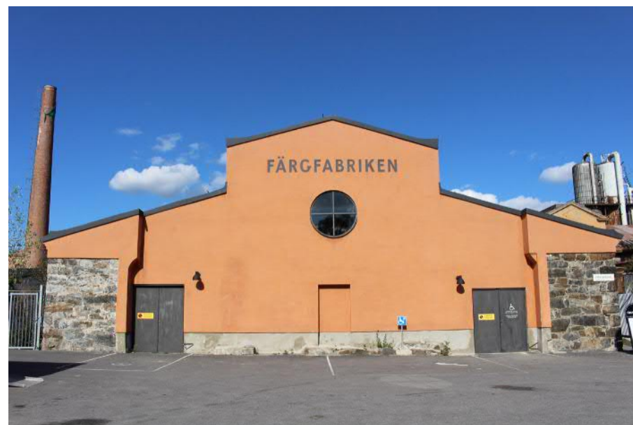
Södra fasaden utgörs av en putsad fasad i en våning samt det upphöjda mittpartiet. Naturstensmuren som präglar långsidornas fasad syns på var sida. Det runda fönstret togs upp i samband med 1990-talets ombyggnation.
