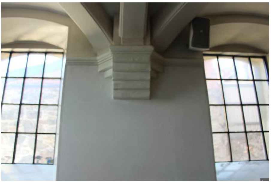
Spröjsade gjutjärnsfönster sitter i stickvalvsformade nischer. Mot väggarna avslutas valvbågarna med profilerade anfangar.
