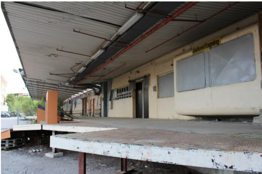
Lastkajen mot nordost med trapetskorrugerat plåttak. Till höger en utskjutande kur i formajuten betong som användes för godsmottagningen.
