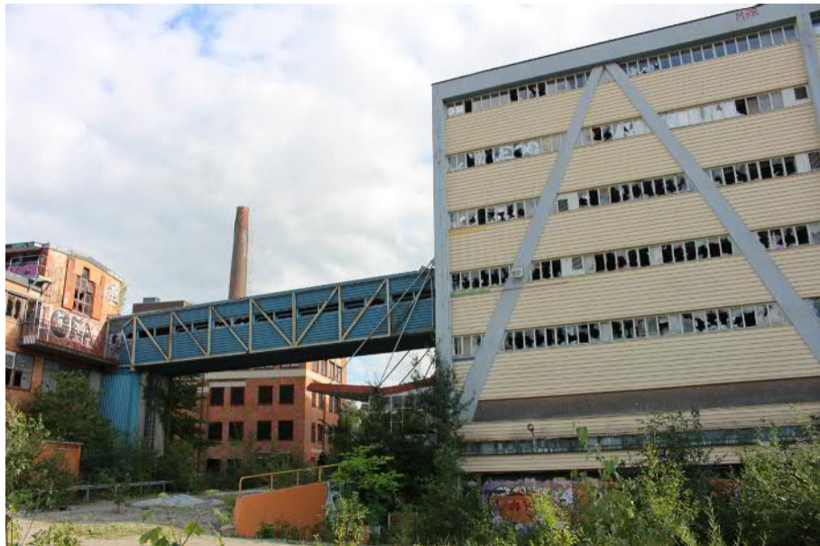
Förbindelsegången mellan Nitrolackfabriken (vänster) och Spredfabriken (höger) utfördes i fackverkskonstruktion och anknyter på så sätt till Spredfabrikens utformning. Förbindelsegången tillkom på 1990-talet i samband med att Nitrolackfabriken byggdes om till lager som försörjde Spredfabriken med råvaror.
