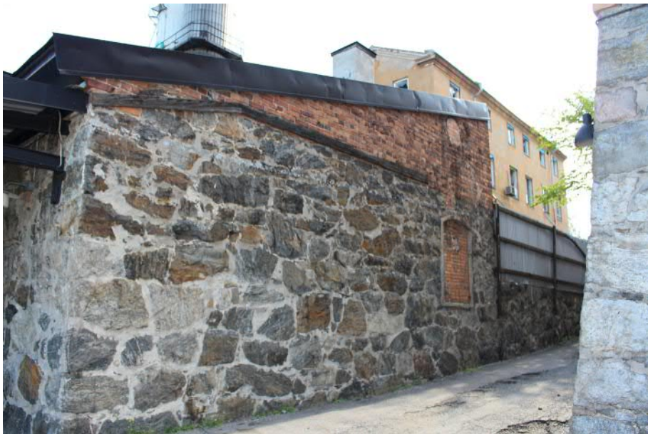
På den sydvästra gaveln mot Färgfabriken finns spår efter bjälklag samt igenmurade öppningar från idag rivna byggnader.
