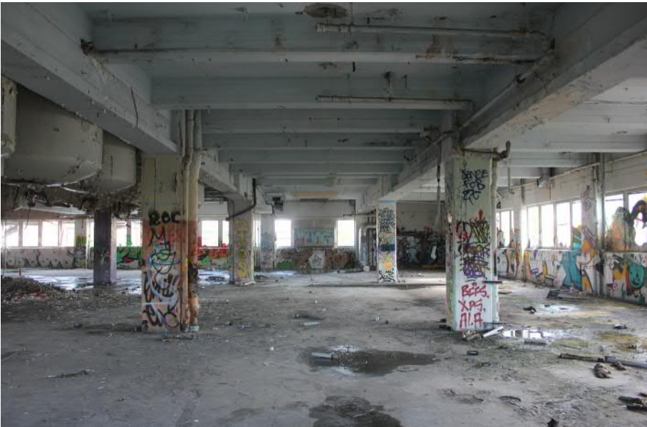
Nya färgfabriken med bärande pelare av betong. Klotter präglar både väggar och pelare.
