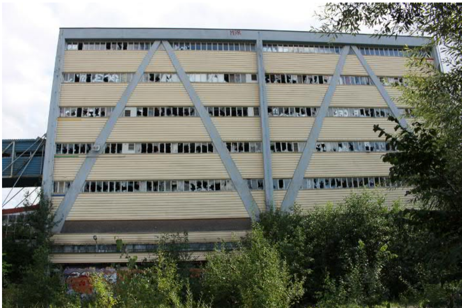
Fasad mot nordväst. Den accentuerade betongkonstruktionen kan liknas vid ett fackverk med de höga snedställda betongstagen som skapar ett monumentalt intryck. Ett på bottenvåningen är igensatt.
