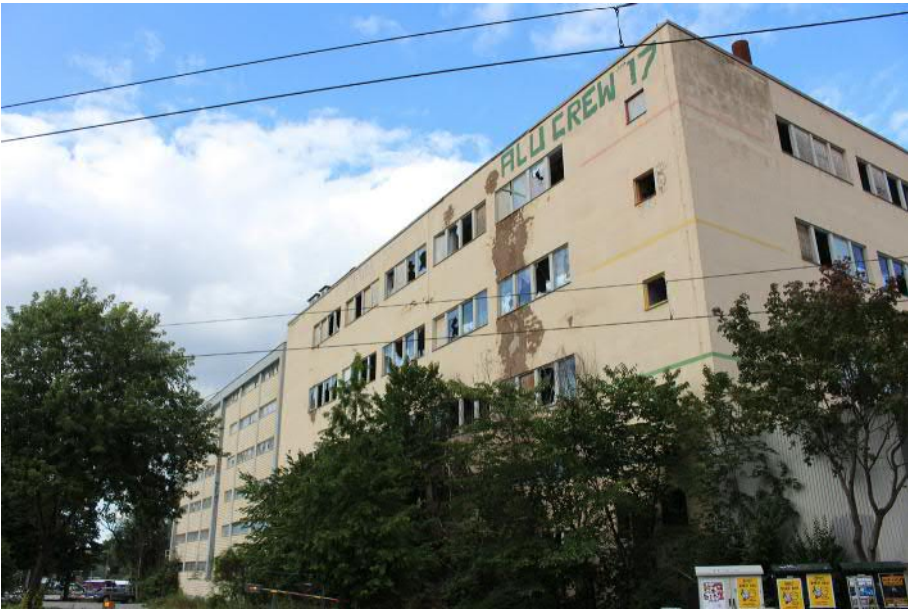
Nya färgfabriken sett från Lövholmsvägen. Fasaden har stora putsbortfall som blottar den tidigare bruna fasadkulören. Trapphusfasaden markeras med kvadratiska enlufts-fönster som målats i olika kulörer i likhet med de linjer på fasaden som markerar våningsplanen. Färgmarkeringen tillkom sannolikt i samband med omfärgningen av fasaden på 1990-talet.
