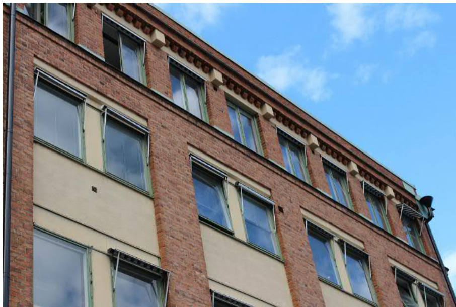
Fasaden har flera klassicerande detaljer så som fasadindelningen med utskjutande lisener i tegel och indragna putsade fasadfält. Kransgesimsen och tandsnittsfrisen är också exempel på klassiska stildrag.
