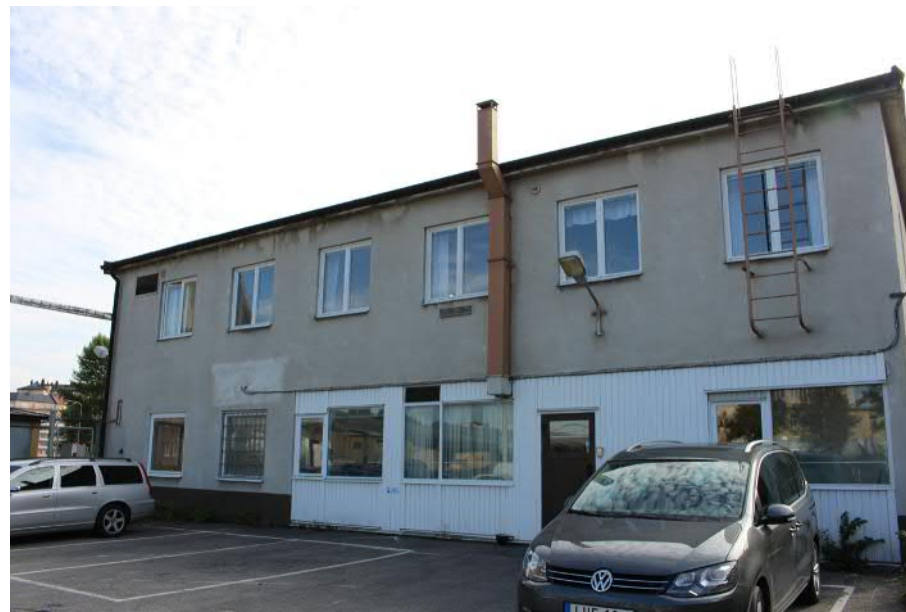
Västra fasaden. Del av bottenvåningen har försetts med träpanel och nya fönster när de ursprungliga garageportarna togs bort.
