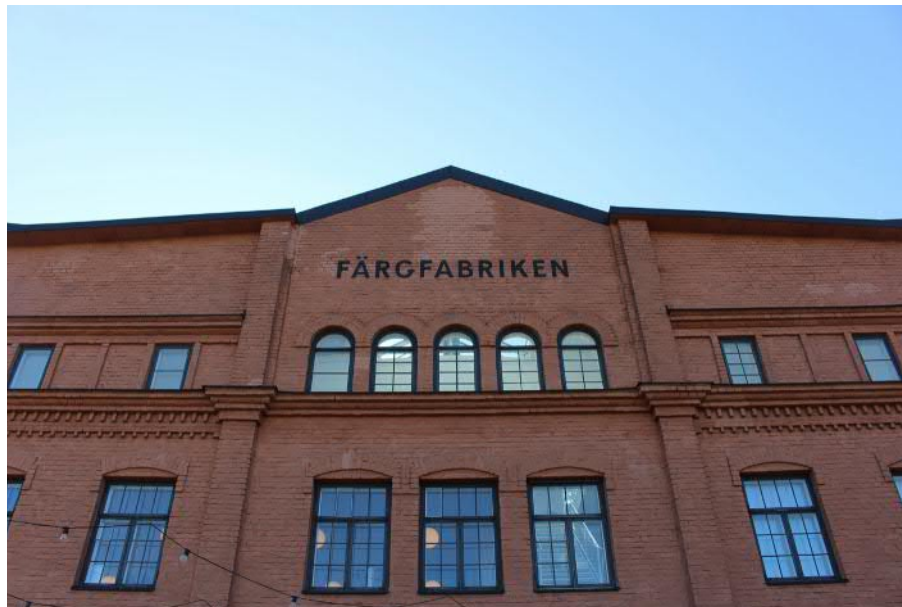
Den norra delens takutförande tillkom i början av 1950-talet då taket höjdes en och en halv meter och den centrerade lanterinen tillkom.
