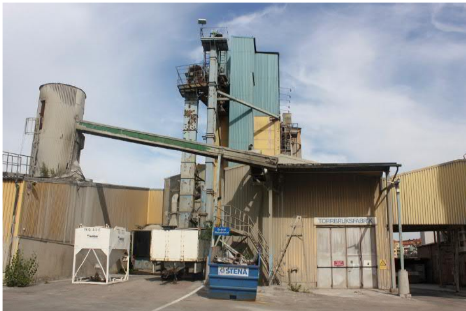
Torrbruksfabriken. Till vänster skymtas fyllningsfickor för ballast som kom på lastbil.
