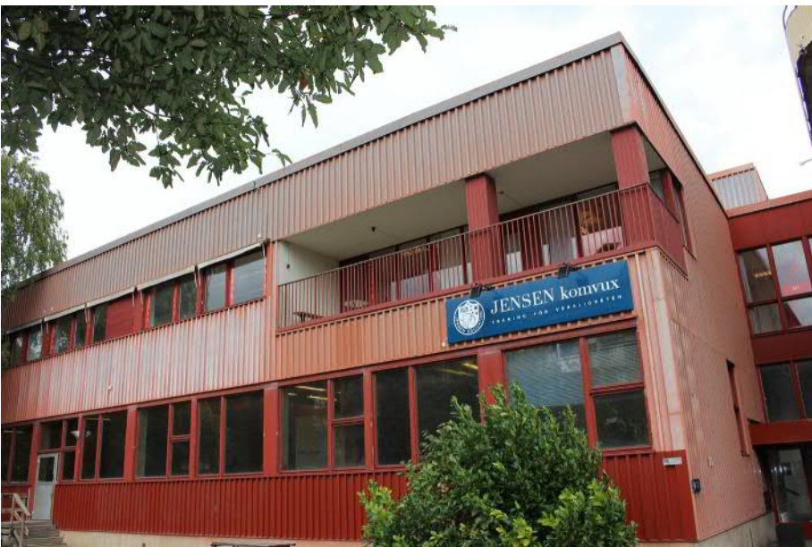
Fasad mot Lövholsvägen. Fönstren är placerade i fönsterband och har varierad storlek och indelning.
