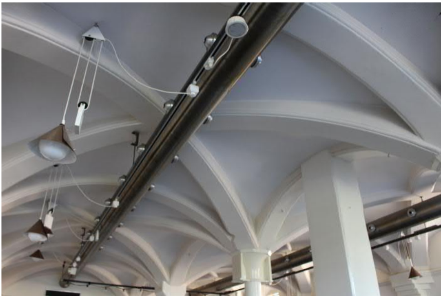
Den ursprungliga takvalvskonstruktionen med kryssvalv är synlig i bottenvåningen.
