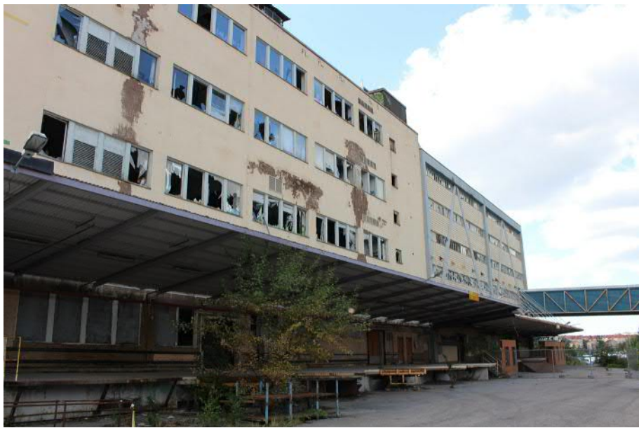
Skärmtak över lastkaj med trapetskorrugerat skärmtak. Ursprungliga röda lastportar och dörrar.
