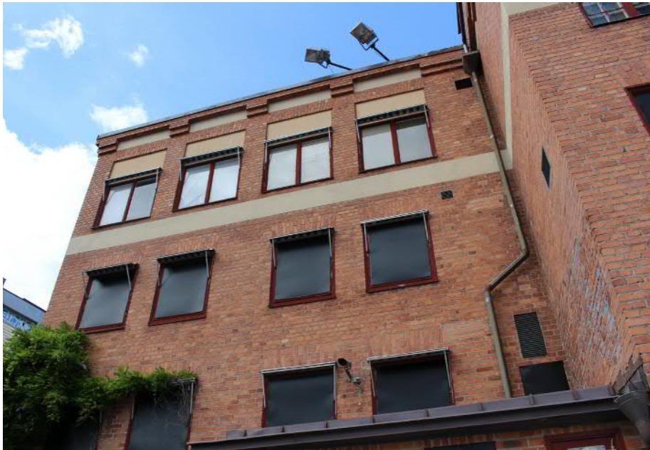
Ett putsat fasadband löper mellan den tredje och fjärde våningen. I övre våningsplanet finns svagt utkragande murade lisener. En klassicerande takfotslist löper längs med byggnaden.
