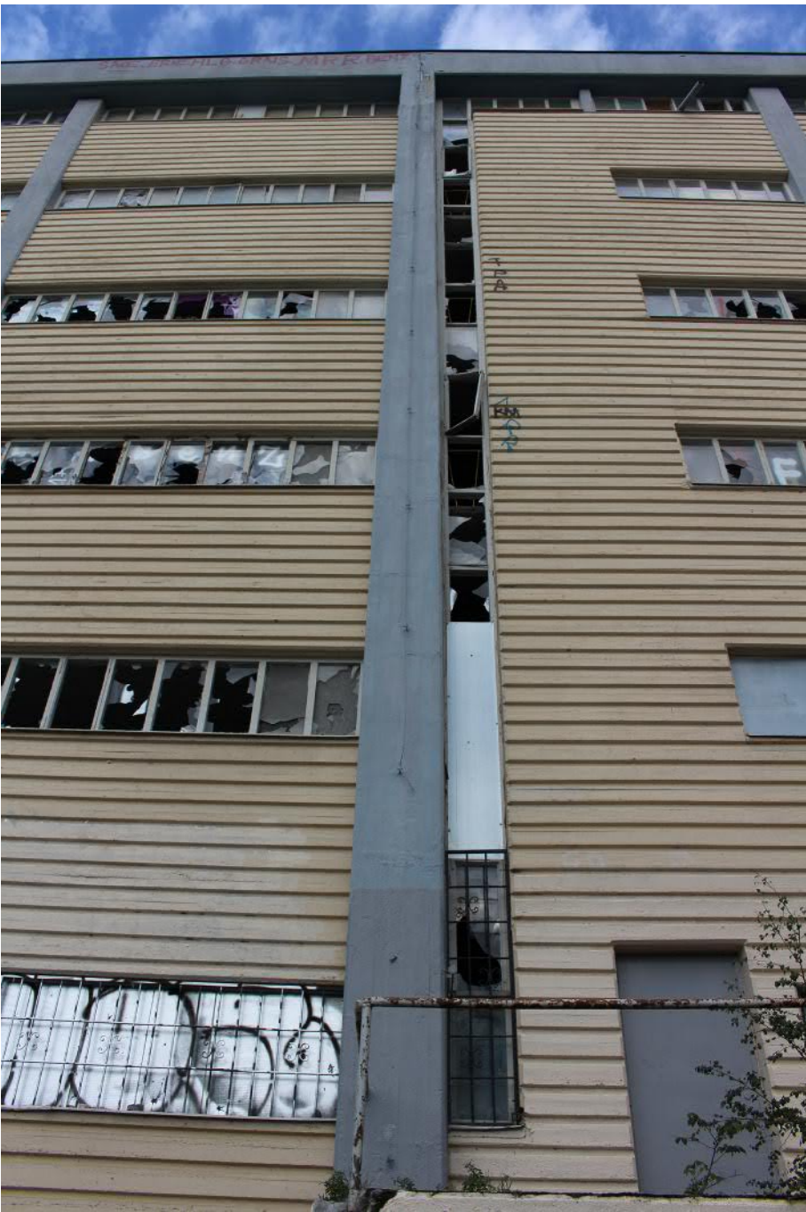
Fasad mot sydväst. Här finns en vertikal fönsterslits som är genomgående genom alla våningar och markerar läget för ett av trapphusen.
