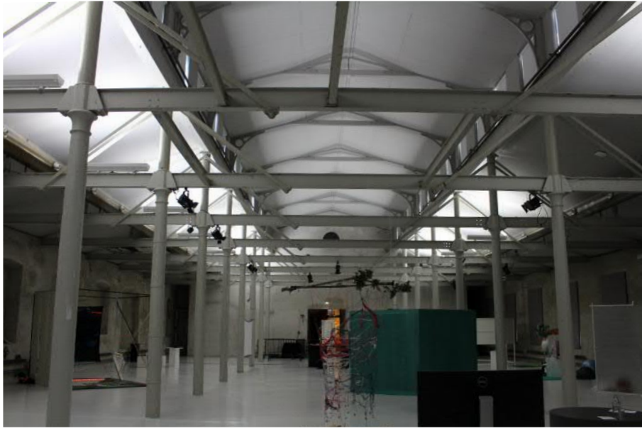
Byggnadens södra del, den före detta produktionslokalen, används idag som utställningslokal. Ursprunglig stomme i gjutjärn och stål.
