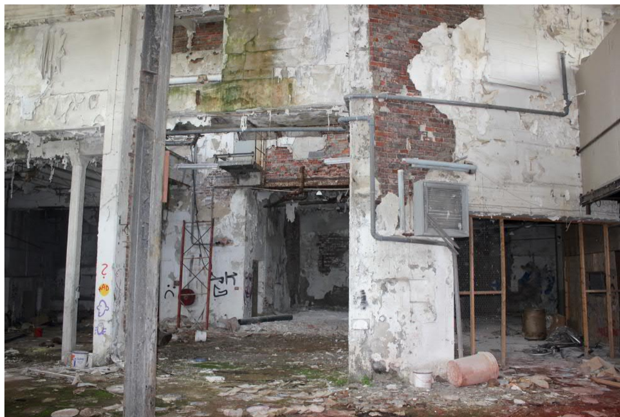
Del av bottenvåningen i vad som enligt uppgift var pannrummet. Tidiga tegelkonstruktioner och senare tillägga av armerad betong kan avläsas. Uppe till höger kan ett tidigare fönster anas.
