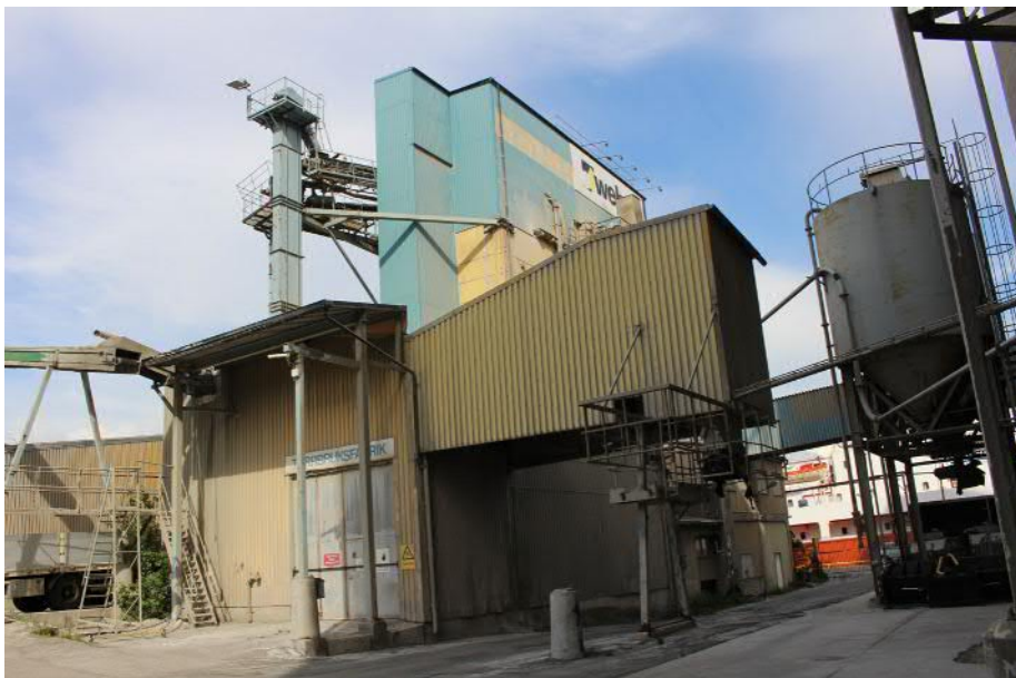
Lastplats för bulkutlastning av torrbruk.
