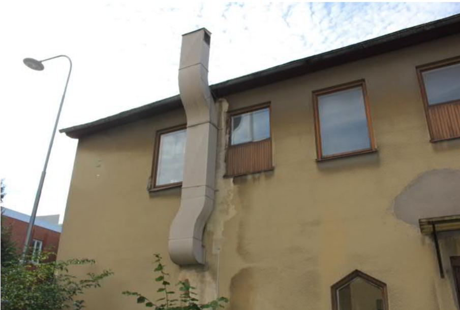
Ventilationsrör från omklädningsrummet
