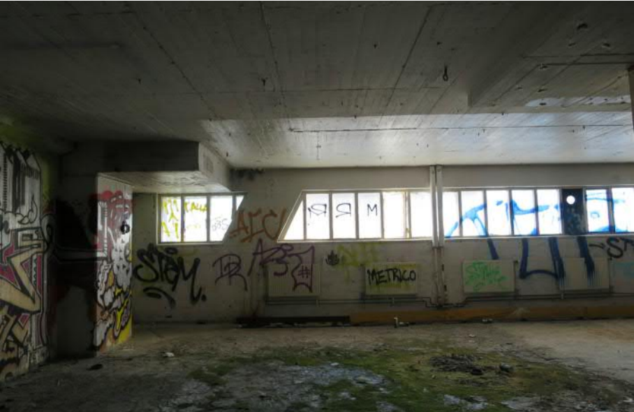
Interiör från Spredfabriken. De diagonalställda betongstagen syns även från insidan.
