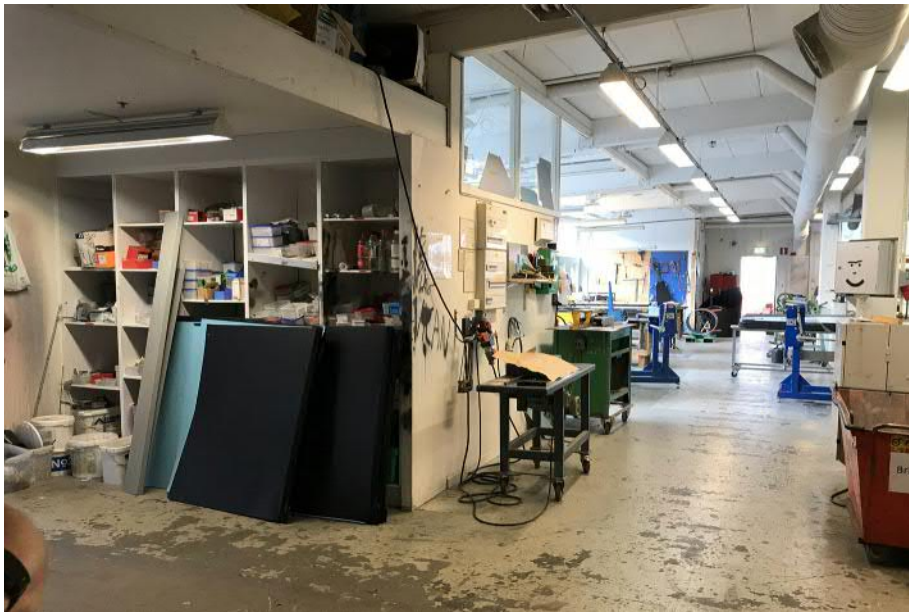
Del av bottenvåningen har verkstadskaraktär med gjutet, målat betonggolv och inredning av tillfällig karaktär.
