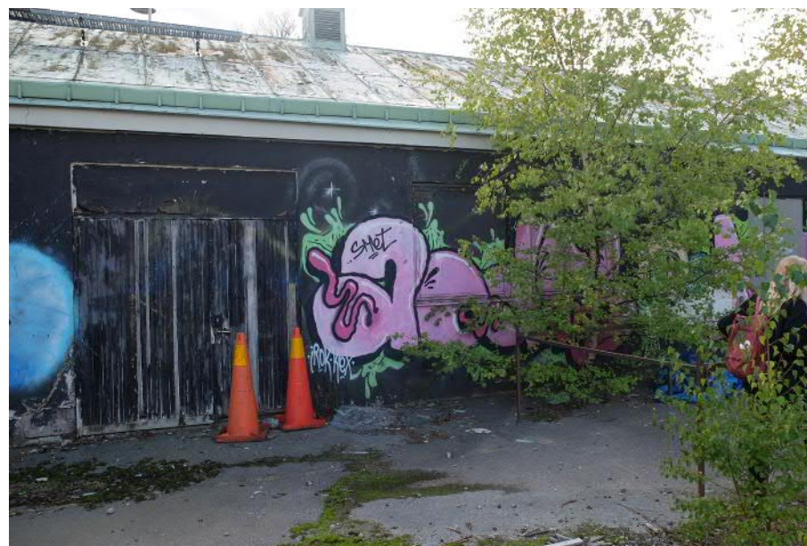
Den före detta garagelängans fasad mot nordväst inifrån området. Gargageportarna sattes igen vid 1960-talets ombyggnation till laboratorium. Fasaderna är i nuläget svartmålad och har större grafittimålningar.
