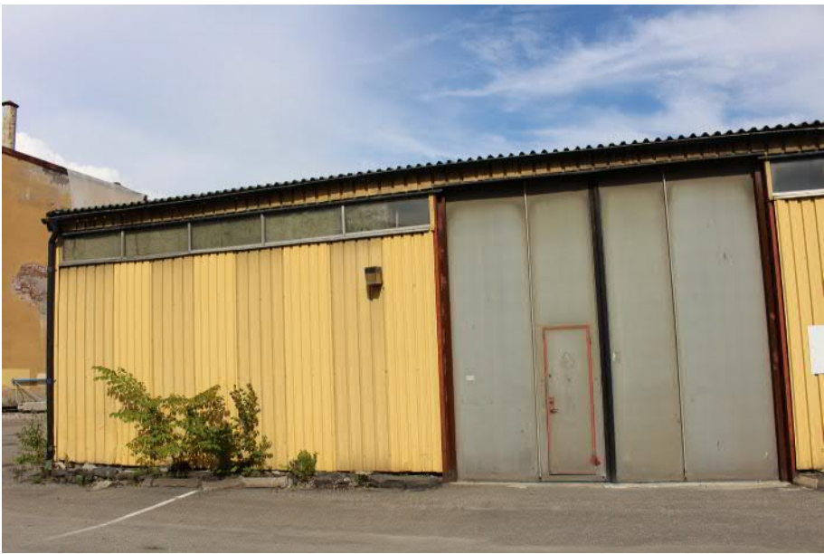
Magasinet har fasader och takbeläggning av korrugerad plåt. Högt placerade fönsterband finns på delar av fasaderna.
