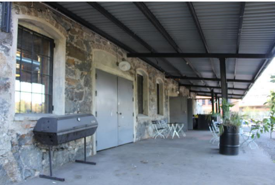
Entréfasaden mot norr flankeras av ett korrugerat skärmtak som vilar på en stålkonstruktion.
