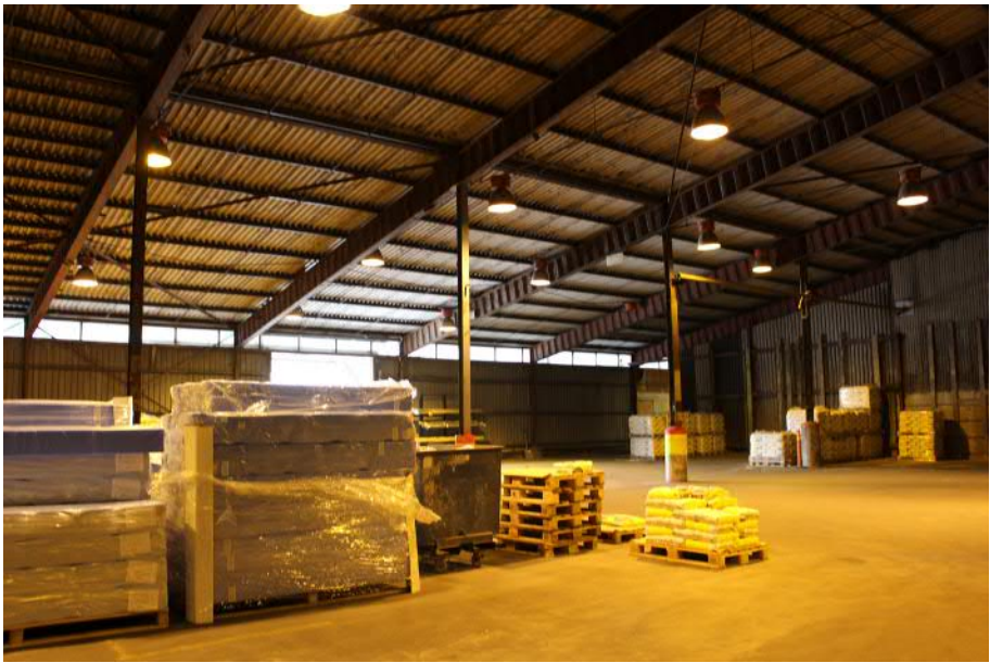
Magasinen har en bärande konstruktion i stål och tak i korrugerad plåt.
