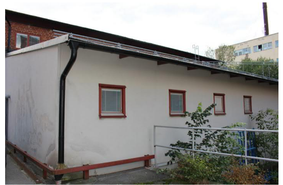
Den putsade lågdelen mot norr. Tidigare bestod utbyggnadens fasad av glasade ytor i ett ramverk av stål.
