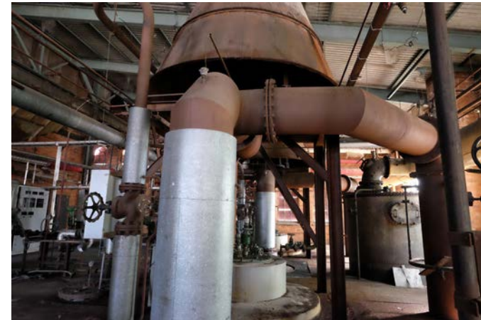
Överdelen på överhettaren skars av 1968 och försågs med vindbox.
