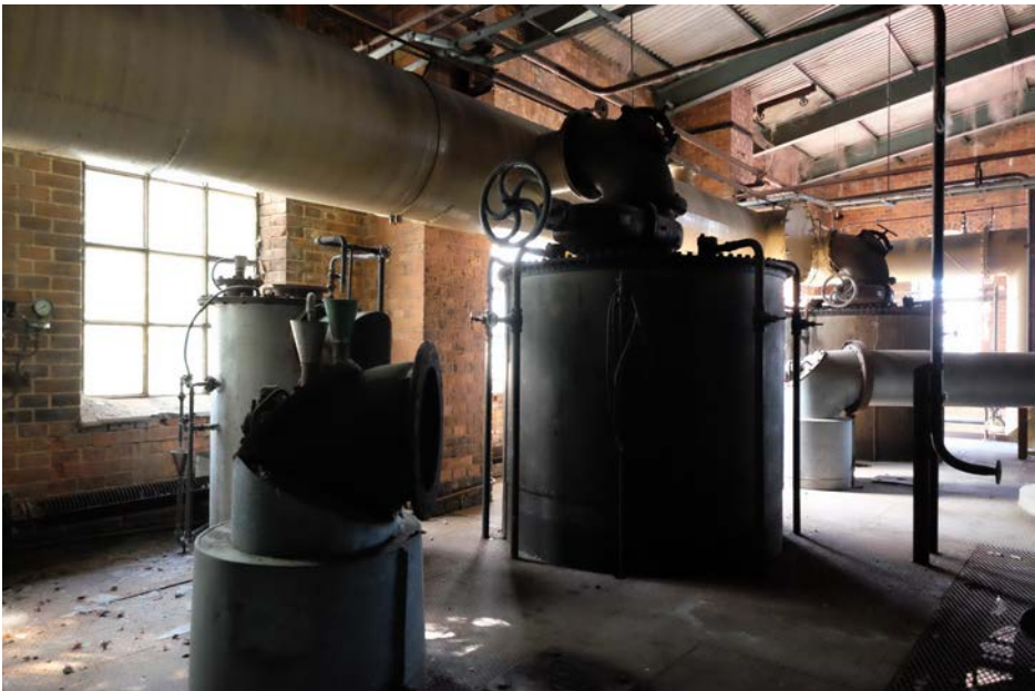
Skrubbrarnas överdelar med huvudgasledningen.
