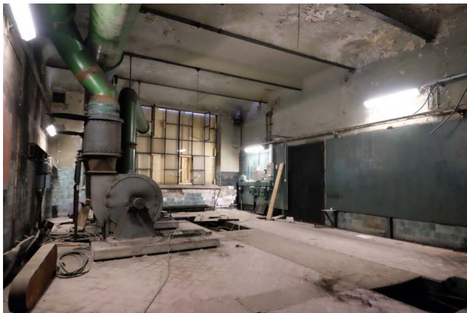
Maskinrummet. Fläktarna är från 1939, till viss del ombyggda 1968. Glacerat kakel på väggar och schakt i golv är ursprungliga.
