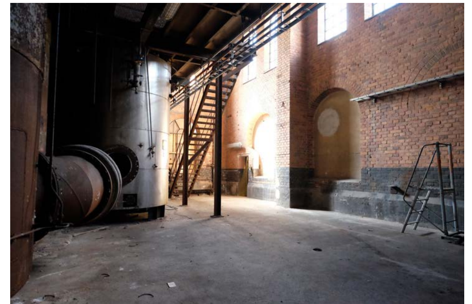
Generatorrummet. Från vänster; genrator, ångpanna och trappa från 1968, fönsteröppningar igensatta 1939. På den öppna ytan till höger stod kylarna fram till 1968.
