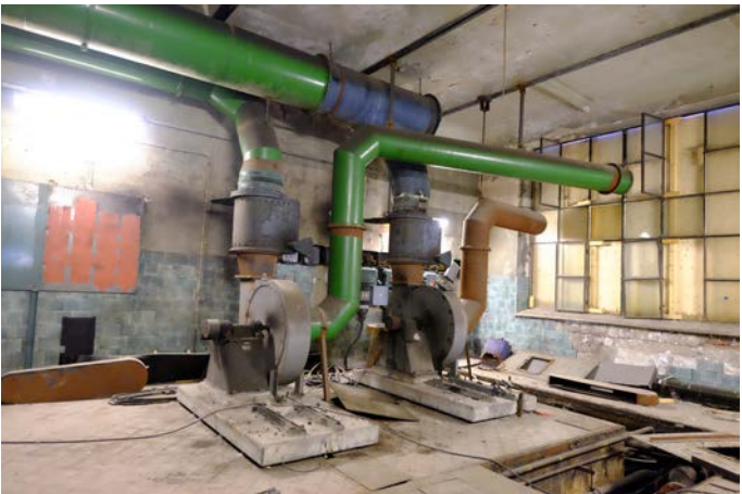
Fläktar, till viss del ombyggda 1968. Luftströmmen gck ursprungligen i schakten i golvet.
