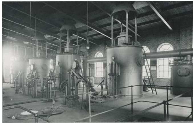
Vattengasverkets manöverplan 1914. Ur denna vy är skrubbers (längst till höger) bevarade i ursprungligt skick samt i viss mån metallracket. Nere till vänster i bild är luckan till generatorn öppen, där koks hålles i för hand. Trätaket ersattes med eternit 1939. Foto: Gutav Anckert. Källa: SSM
