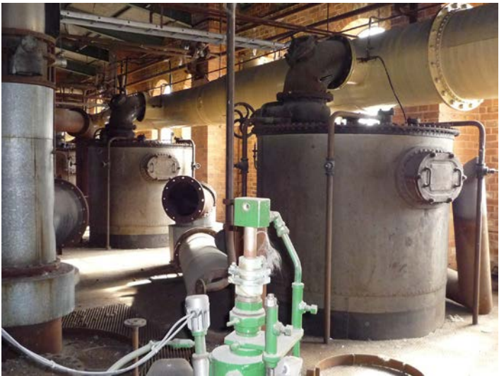
Vattengasverkets manöverplan. Överdelarna av scrubbrarna är ursprungliga, rören ersattes med de nuvarande 1939. Foto: Urban Nilsson, Nyréns 2009.
