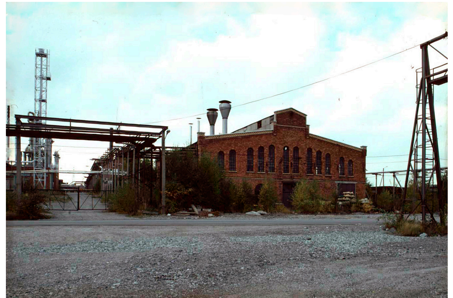
Vattengasverket från öster 1982. Större förändringar exteriört vid ombyggnaden 1968 var rivning av koksbandet och skorstenen, förändring av två skorstenar på södra takfallet samt portbyten. Spaltgasverket (efterföljaren till experimentverket) till vänster i bild. Foto: okänd. Källa: SSM
