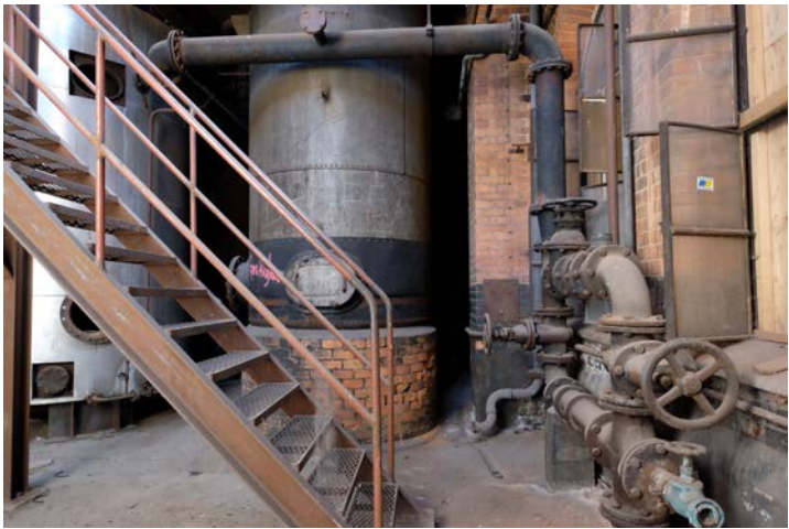
Rördragningen samt scrubbern (med tegelsockel) på bilden är ursprunglig.
