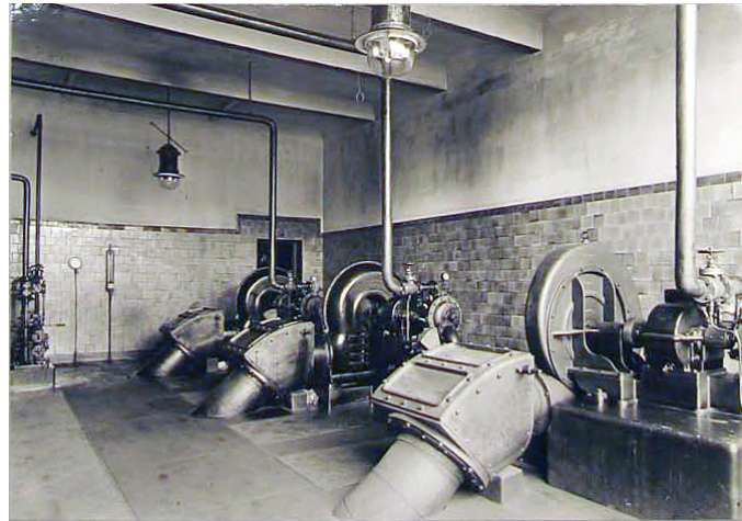
Ursprungliga fläktsystemet i maskinrummet. Fläktarna ersattes 1939. Det färgade kaklet på väggarna är till stora delar bevarat. Foto: Gutav Anckert. Källa: SSM
