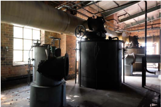
Rören blev grövre vid ombyggnaden 1939 från att ha haft en mer smäcker konstruktion. Skrubbern i mitten av bilden är intakt från 1909 men är kopplat mot ett grövre rör från 1939.
