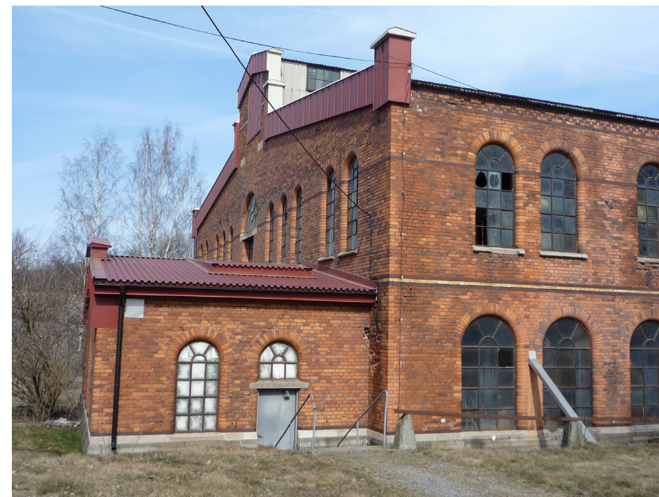
Södra fasaden. Den lägre delen var ursprungligen pumphus. Lanterninen kläddes in 1939. Plåtinklädning och tak sentida. Foto: Nyréns 2009
