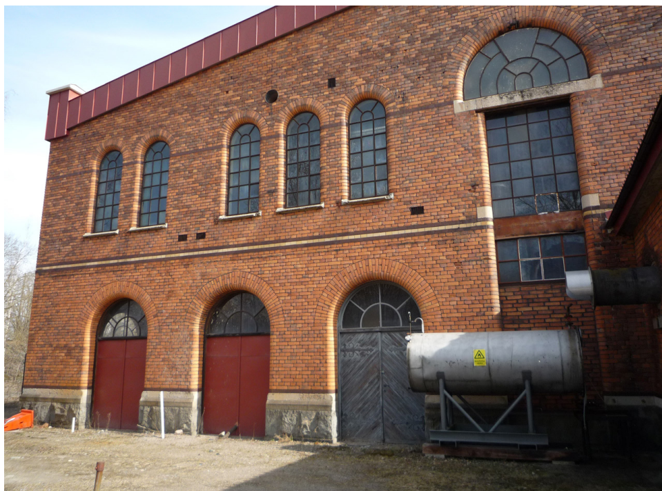
Västra fasaden. Den enda porten med ursprungliga dörrblad centralt i bild. Bakom tanken en sentida igenmurad öppning. Foto: Nyréns 2009
