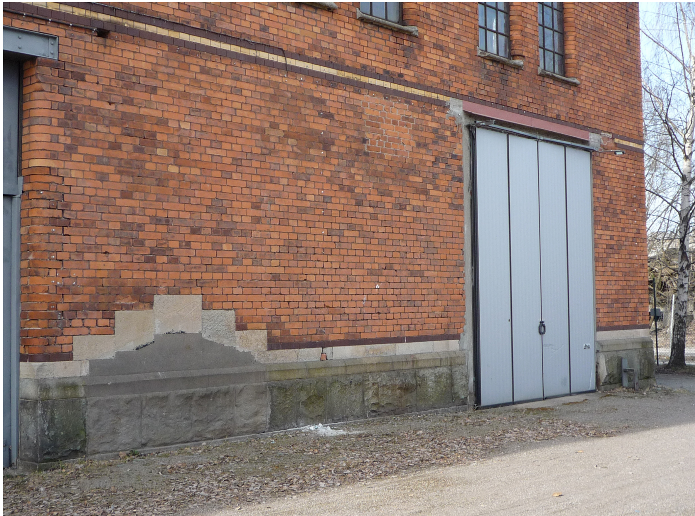
Östra fasaden. Porten till höger i bild är sentida, dess muröppning förstörades sannolikt 1968 i samband med att ångpannorna togs bort. Foto: Nyréns 2009
