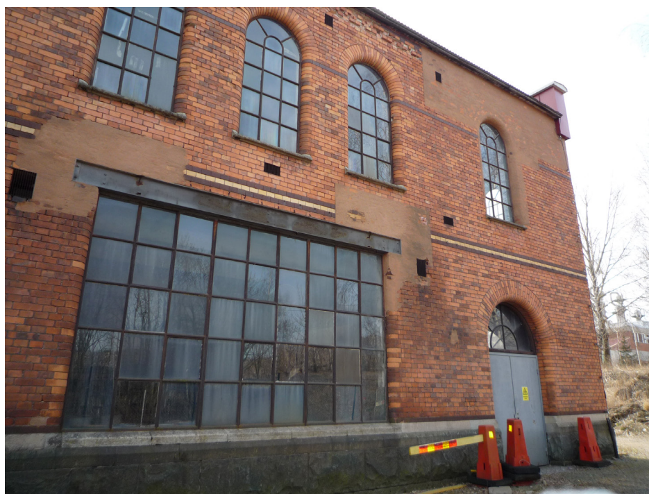
Norra fasaden. Fönster till maskinrummet med stålbalk sannolikt ursprungligt. Dörrblad till tjärrum 1968 eller senare. Foto: Nyréns 2009
