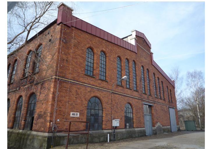
Östra fasaden. Porten i mitten ersattes 1939 (jmf ritning till vänster), porten längst till höger är sentida, dess muröppning förstörades 1968 när ångpannorna togs bort. Mellan portarna en igenmurad öppning i sockeln. Foto: Nyréns 2009
