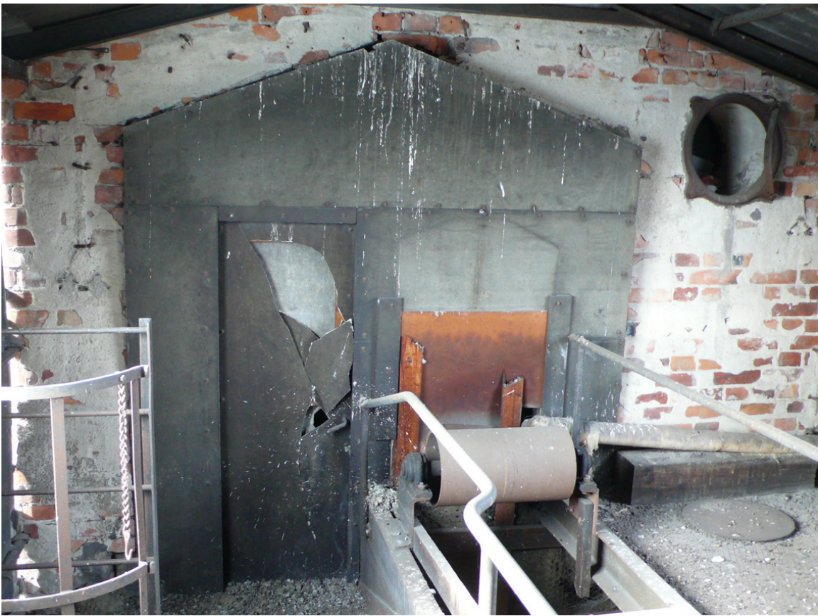
Vid ombyggnaden ersattes ett fönster i lanterninens västra del med koksintaget (idag igensatt). Foto: Nyréns 2009
