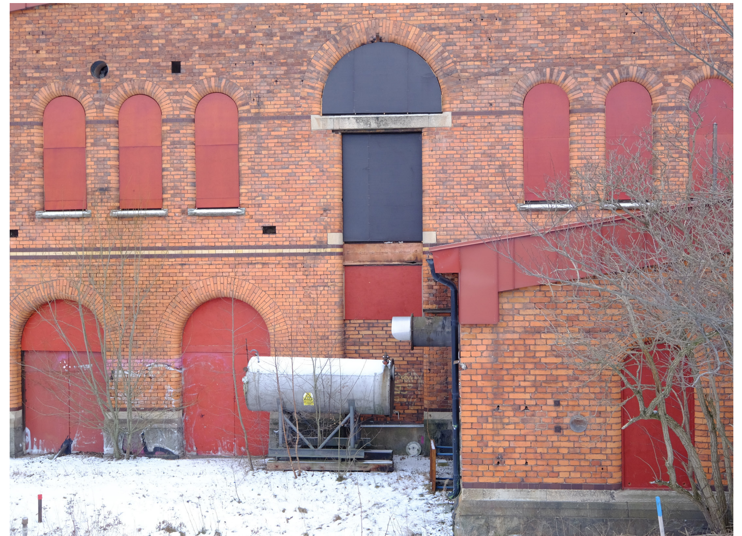
Västra fasaden. En port centralt i bild murades igen och en plattform framför kläddes in i plåt 1968. Ovanpå tillkom en större rördragning, varav enbart en liten bit finns kvar. Även plattformen och dess inklädnad har senare tagits bort. Foto: Nyréns 2018
