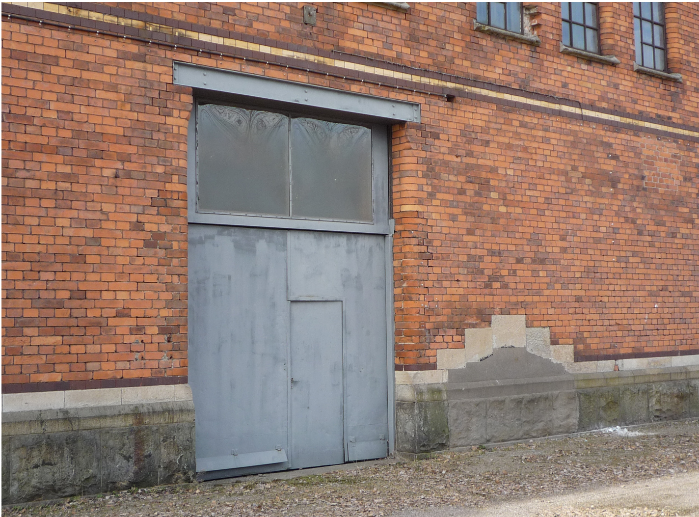
Östra fasaden. Port från ombyggnaden 1938-40. Muröppningen till höger om porten murades sannolikt igen vid samma tillfälle. Den pågjutna betongen har getts samma utformning om den omgivande granitsockeln. Foto: Nyréns 2009
