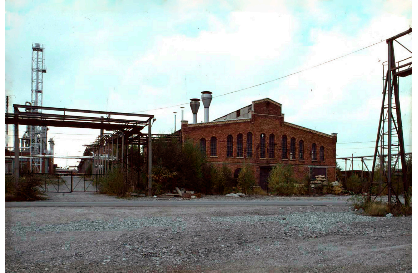
Vattengasverket från öster 1982. Större förändringar exteriört vid ombyggnaden 1968 var rivning av koksbandet och skorstenen, förändring av två skorstenar på södra takfallet samt portbyten. Spaltgasverket (efterföljaren till experimentverket) till vänster i bild. Foto: okänd. Källa: SSM
