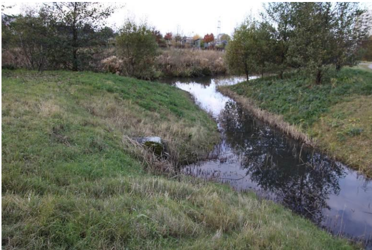
Figur 22. Dike för dagvattenavledning, Årstafältet Stockholm. Foto: Daniel Larsson.
