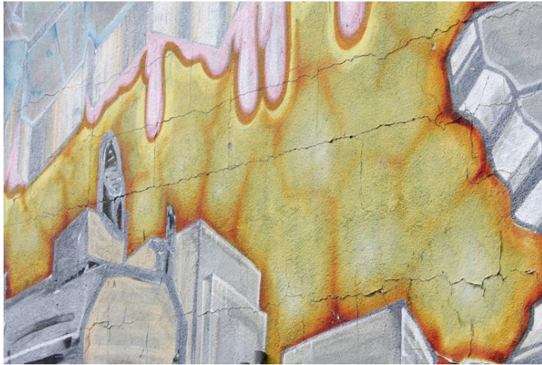
Foto: Sprickbildning mellan betongblock
