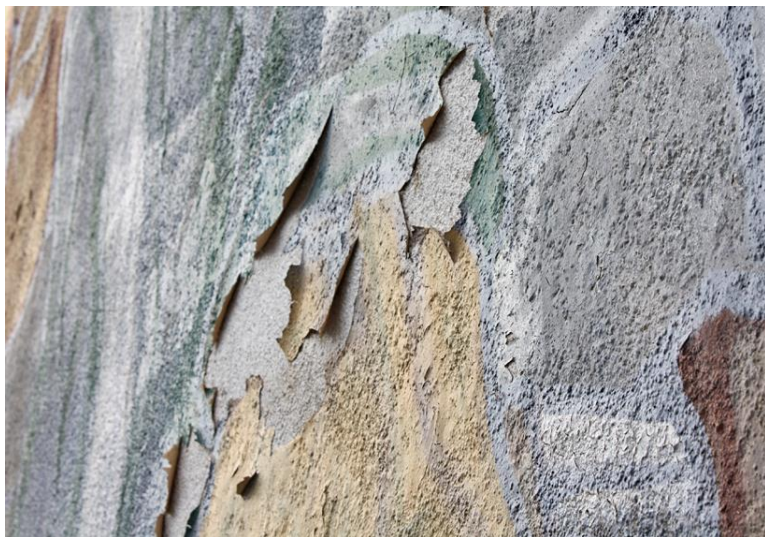
Foto: Område med flagande färg där färgen släpper ifrån den putsade ytan, mars 2011
