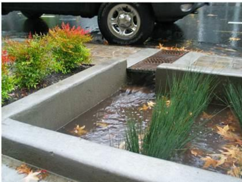
Figur 4. Exempel på ett släpp i kantsten för att leda in vatten till översvämningsytan.
