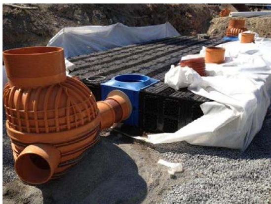
Figur 8. Dagvattenkassett och kassettmagasin under anläggning.
