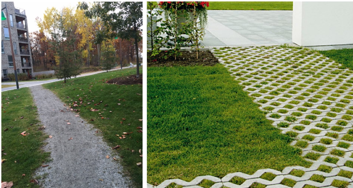
Figur 7. Bilder på genomsläppliga beläggningar. Grusad yta i vänstra bilden, och markarmering i betong i högra bilden.
