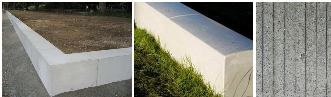
Exempel på låga murar i prefabricerade element samt platsgjuten mur med brädform.
