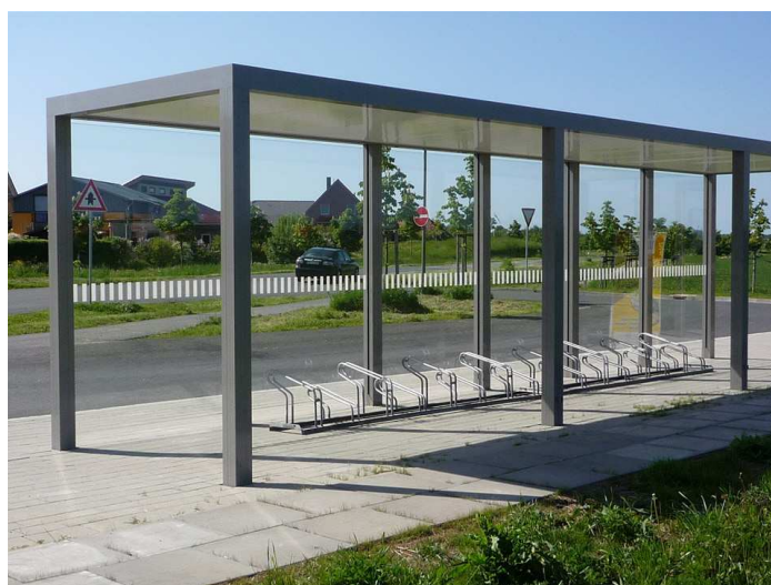
Exempel på cykeltak med rektangulär form och öppna långsidor
