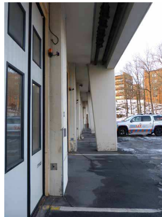
Vagnhallens nordfasad med synligt betongbjälklag på pelare med indragna portöppningar.
