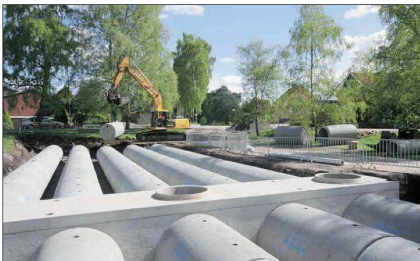
Figur 9. Exempel på utjämningsmagasin bestående av rörpaket i betong (Alfarör)
