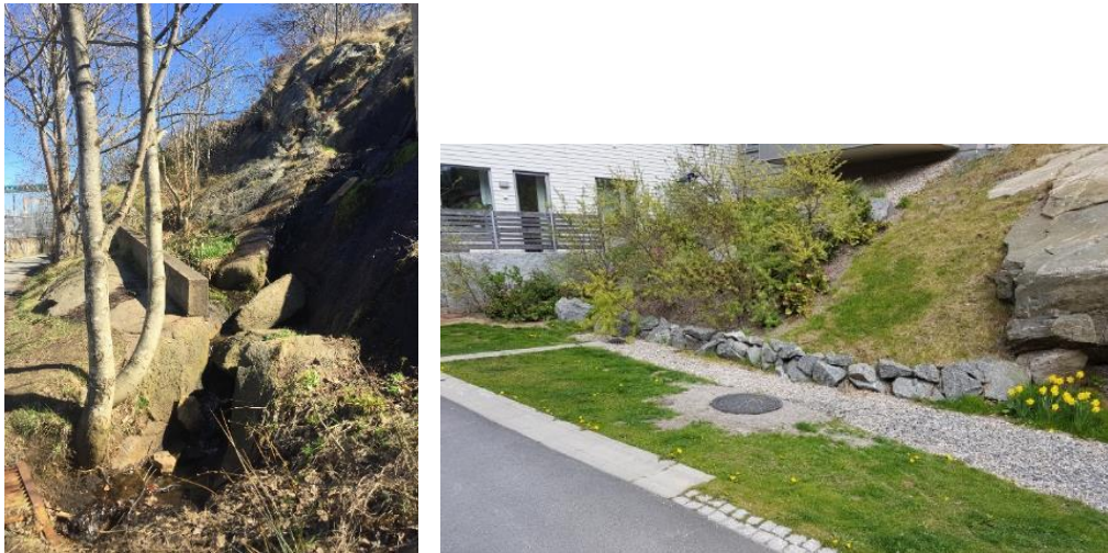
Figur 30. Exempel avskärande åtgärd i form av mur (vänster) och grussträng invid bergsslänten (höger). Foto: Ramboll
