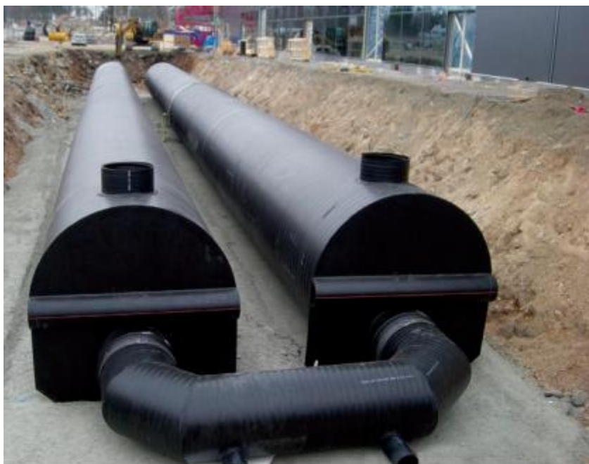
Figur 13. Inspirationsbild: Parallellkopplat rörmagasin från Växjö (Uponor).
