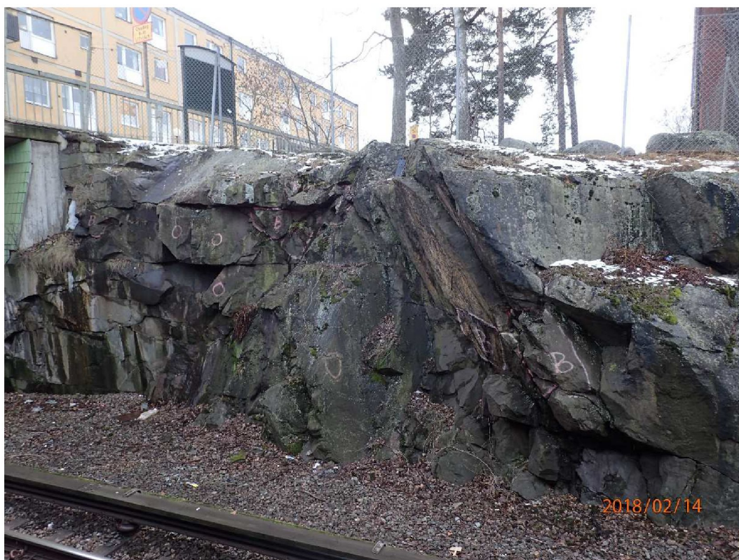
Figur 3.4. Det finns svagheter i bergslänten som behöver åtgärdas.
