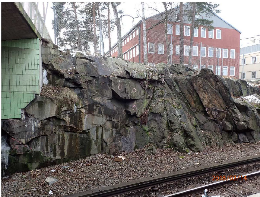
Figur 3.3. Bergslänten är uppsprucken och behöver skrotas samt förstärkas innan schaktarbeten kan påbörjas.
