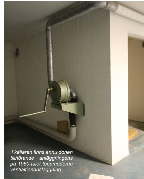
Samtliga trapphus har kvar ursprungskaraktären i ytskikt och trappräcken.. I källaren finns ännu donen tillhörande anläggningens på 1960-talet toppmoderna ventiltionsanläggning.
