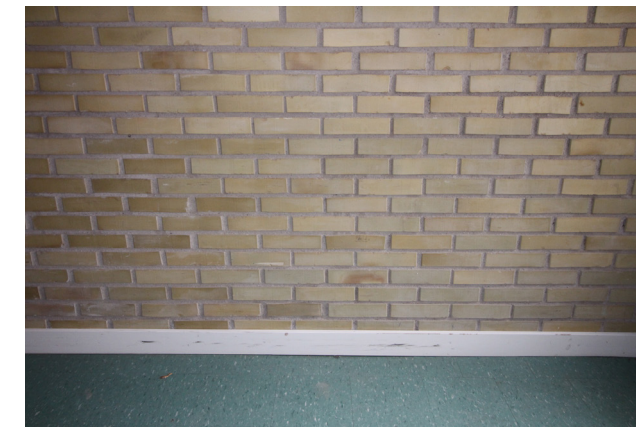
I souterrängvåningen finns spår efter den ursprungliga inredningen med frilagda tegelväggar, enkla vitmålade trälistor och grön linoleummatta.
