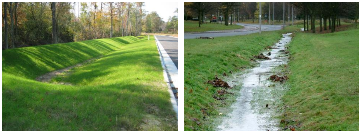
Figur 7. T h Svackdike i torra förhållanden, för aktuellt planområde blir detta normalfallet. T v vattenfylld svackdike.
