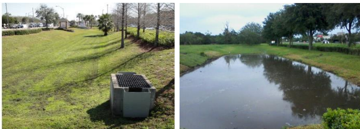
Figur 6. T v gräsklädd torrdamm, diskret i landskapet. T h vattenfylld torrdamm, inträffar i samband med skyfall.
