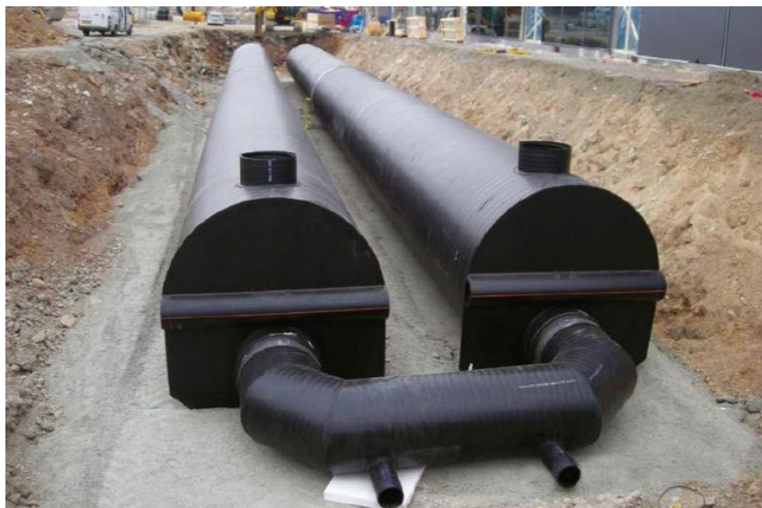
Figur 10-5 Underjordiskt rörmagasin
