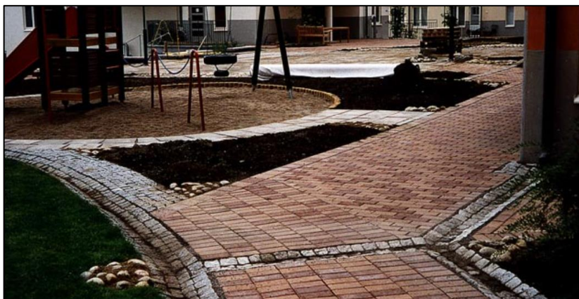
Figur 10-2. Exempel på avledning av takvatten via rännal anlagda med gatsten (Källa: Stockholm Vatten AB, n.d.).
