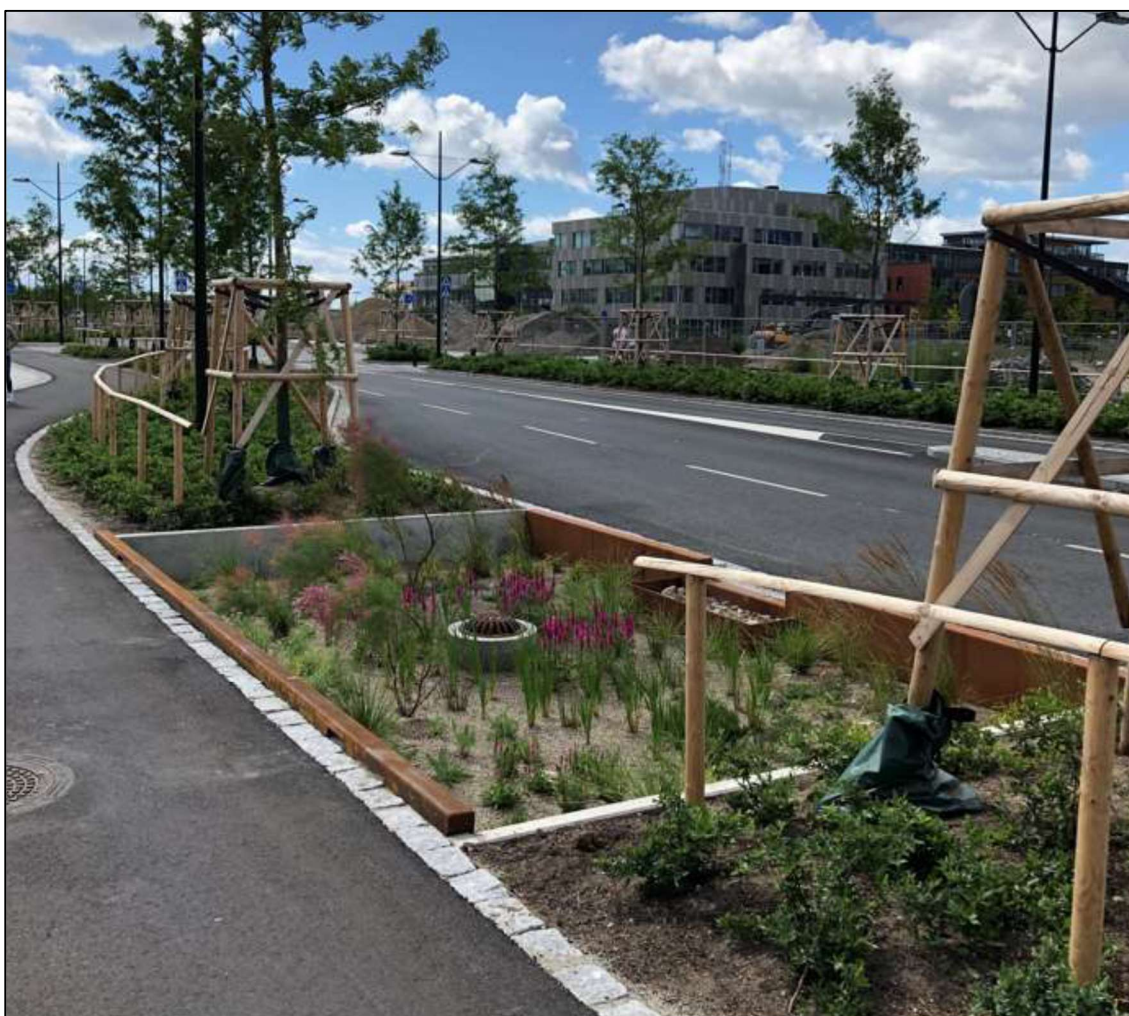
Figur 15. Nedsänkt regnbädd i Malmö med erosionsskydd vid inloppet och bräddutlopp i form av en kupolbrunn. (Foto: Norconsult)
