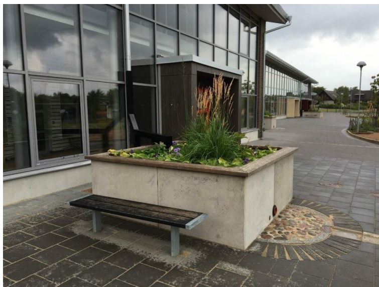
Figur 18. Växtbädd för rening och fördröjning av takvatten (Bildkälla: Kent Fridell)
