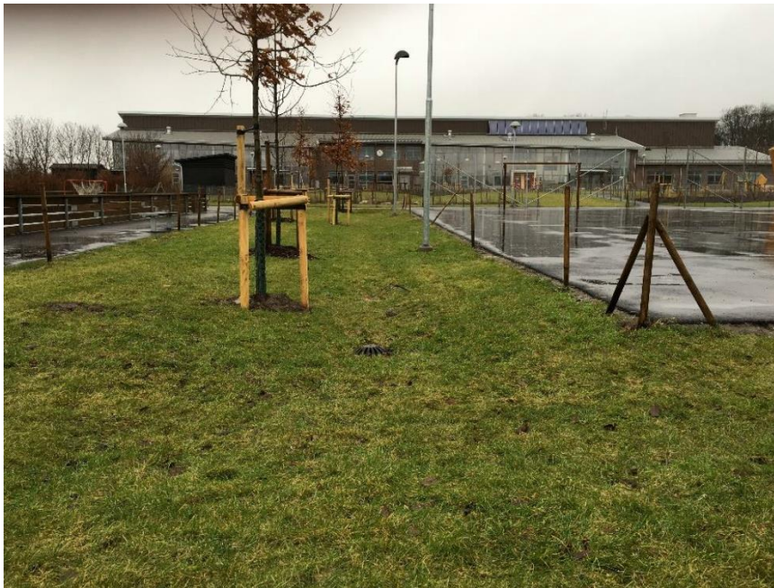
Figur 19. Svackdike med kupolbrunn (Bildkälla: Kent Fridell/SLU)
