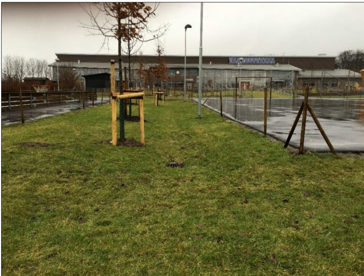
Figur 21. Svackdike med kupolbrunn (Bildkälla: Kent Fridell/SLU)
