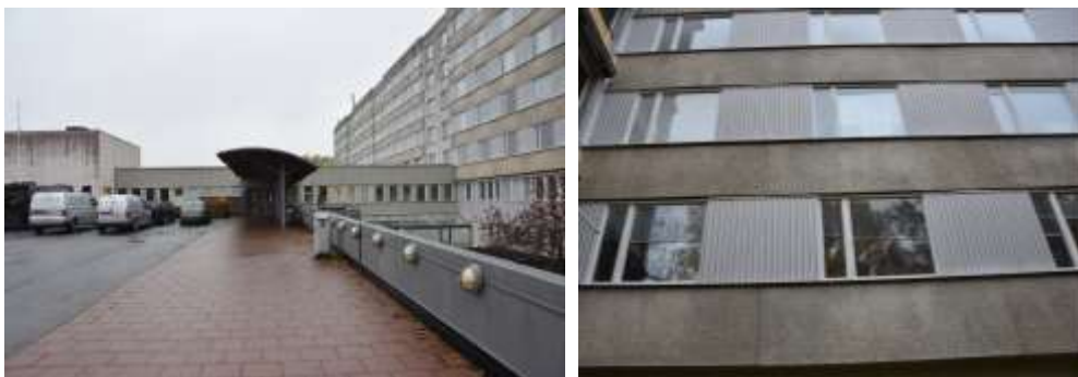
Bild 8–9. Utsikt mot den f.d. sjukhusanläggningens entré samt detalj av fasaden. Lägg märke till anläggningens tidstypiska och modernistiska uttryck med horisontalverkande fönsterband, fasadelement av betong i kombination med korrugerad plåt och putsade ytor. Murar är gjutna i grå betong.
