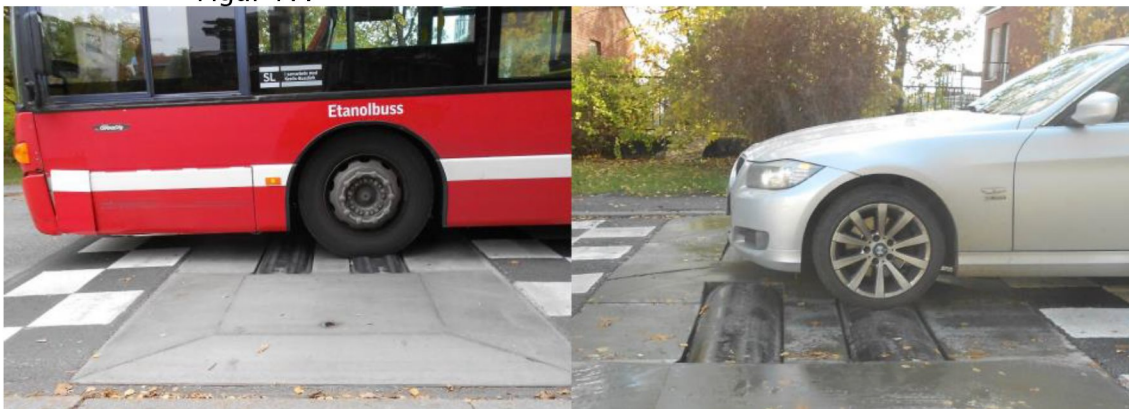
Figur 17. Intelligenta farthinder (IFD) när buss respektive personbil passerar.
