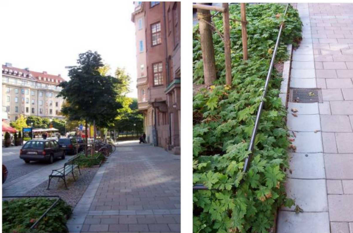
Figur 19. Träd planerade i skelettjord på Erik Dahlbergsallén med anslutande rännstensbrunn (Bildkälla: Stockholm Vatten och Avfall)
