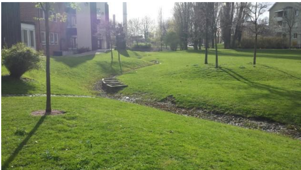
Figur 14. Möjlig utformning av svackdike. Källa: Ramboll
