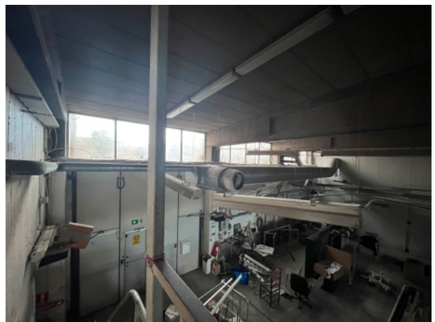
Fd vagnhall, vikportar, fönsterband och betongplank i taket.
