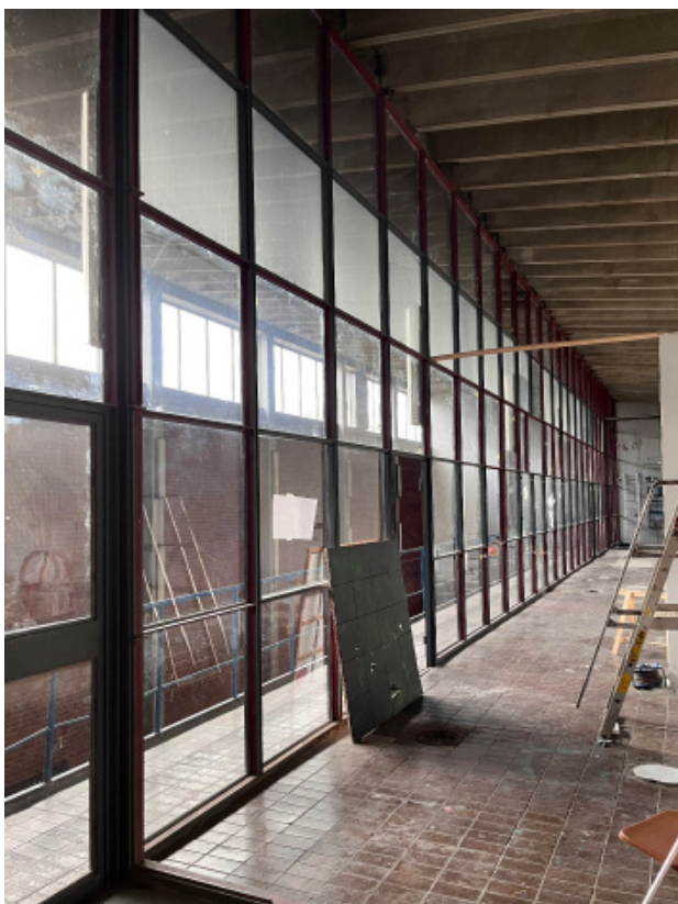
Ateljévåning, stålglasvägg från insidan.
