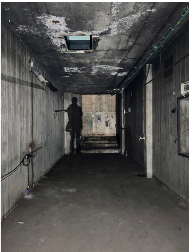
Rum 006, fundamentet till skorstenen igensatt med plywood. .
