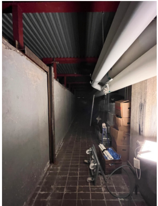
Rum 001, till vänster bjälklag med kvarsittande gjutform synlig i tak. .
