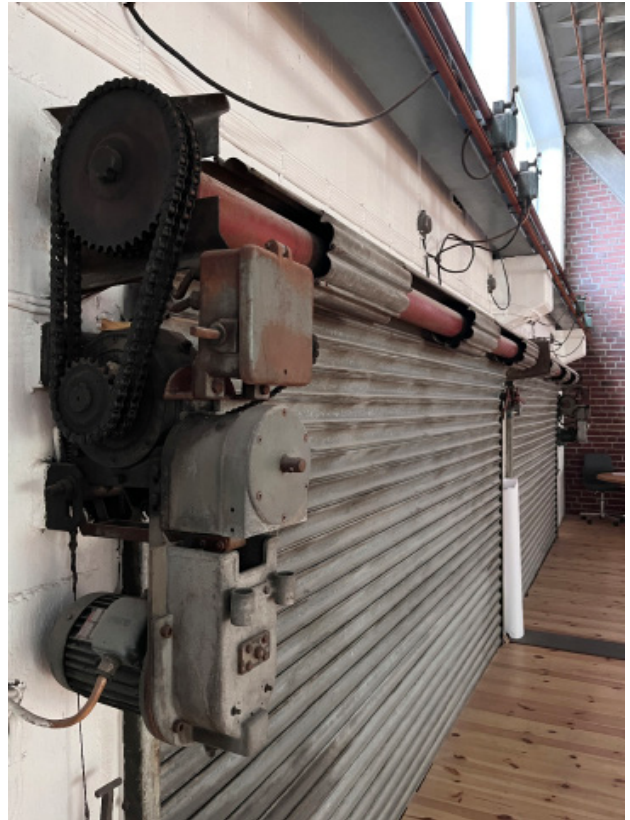
Rum 400, jalousiportar med bevarade motorer.
