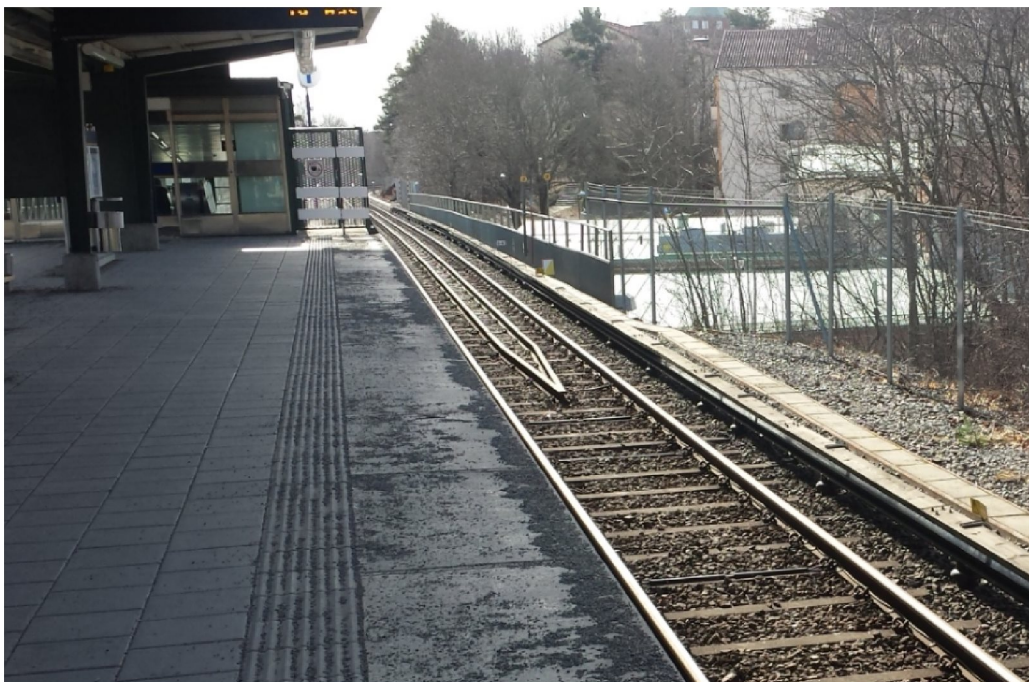
Figur 6. Foto taget i sydlig riktning där urspårningsrälsens placering framgår. Källa: Briab.
