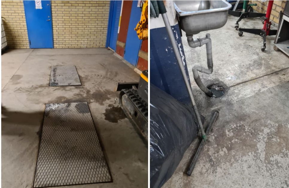
Figur 17. Oljeavskiljare till bilverkstaden, vänster foto. Avloppsbrunn i bilverkstaden.
