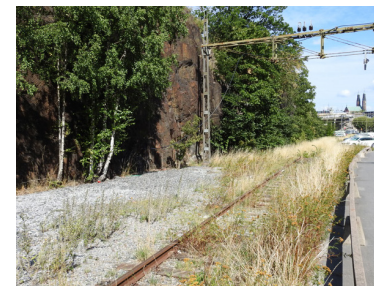
Industrispår längs Södertäljevägens östra sida med kontaktledningsbrygga och armatur från 1930-tal
