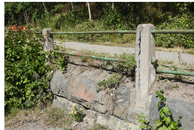
Äldre vägstruktur med stenskodda kanter med räcke.
