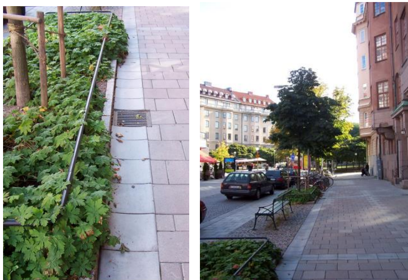
Figur 10. Vänstra bilden visar en vanlig rännstensbrunn som leds till skelettjorden intill. Högra bilden visar träd planerade i skelettjord på Erik Dahlbergsallén (Bildkälla: Stockholm vatten och avfall)
