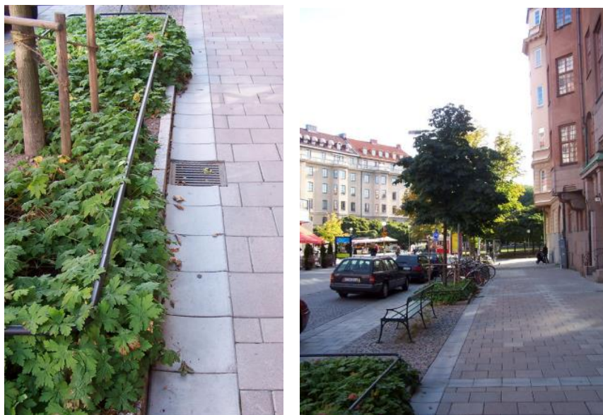
Figur 8. Vänstra bilden visar en vanlig rännstensbrunn som leds till skelettjorden intill. Högra bilden visar träd planerade i skelettjord på Erik Dahlbergsallén (Bildkälla: Stockholm vatten och avfall)
