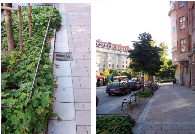
Figur 9. Vänstra bilden visar en vanlig rännstensbrunn som leds till skelettjorden intill. Högra bilden visar träd planerade i skelettjord på Erik Dahlbergsallén (Bildkälla: Stockholm vatten och avfall)
