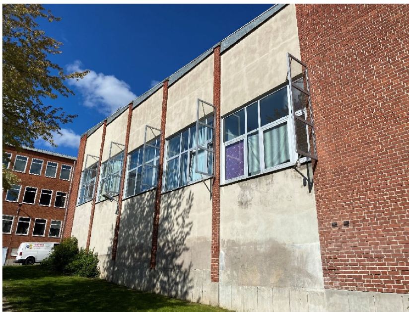
Figur 9. Bullerskärmar med vädringsfönster.
