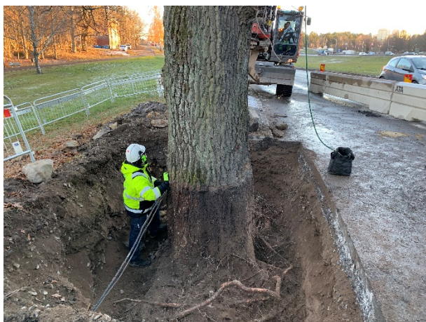
Bild 5 Oskadat rotsystem i den öppnade gropen
