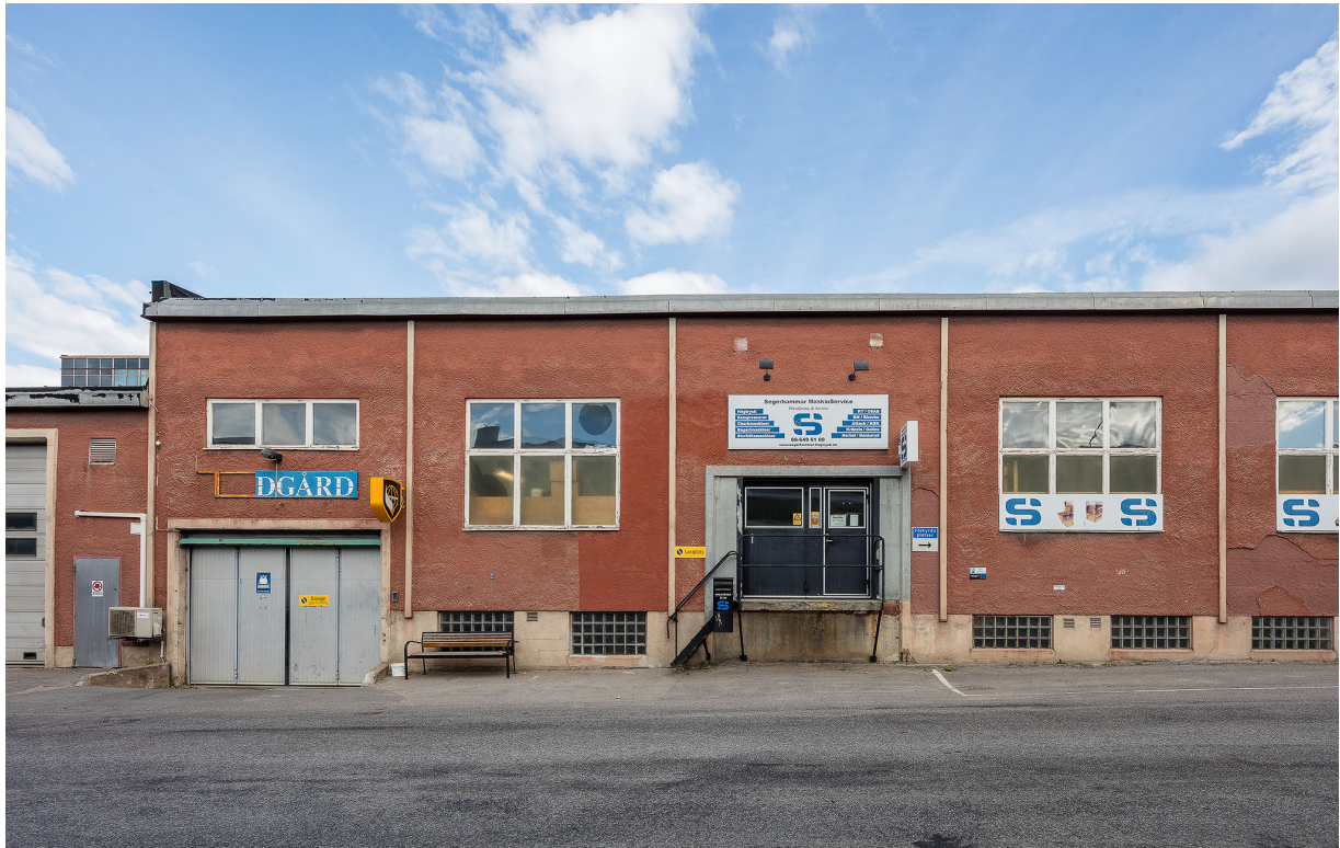
Lågdelen karaktäriseras av sina större fönsterpartier mot de stora lagerhallarna. Notera lastportarnas ursprungliga omfattningar i betong. ME SSM_I0028007.
