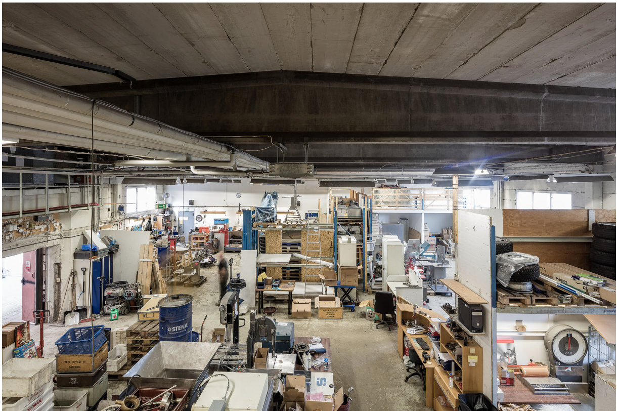
De före detta lagerlokalernas utseende i lågdelen. Ett av de mest värdefulla karaktärsdragen är de öppna rumsvolymerna och den synliga stommen i betong. Här syns de vackert profilerade takbalkarna levererade av Strängbetong. ME SSM_I0027955
