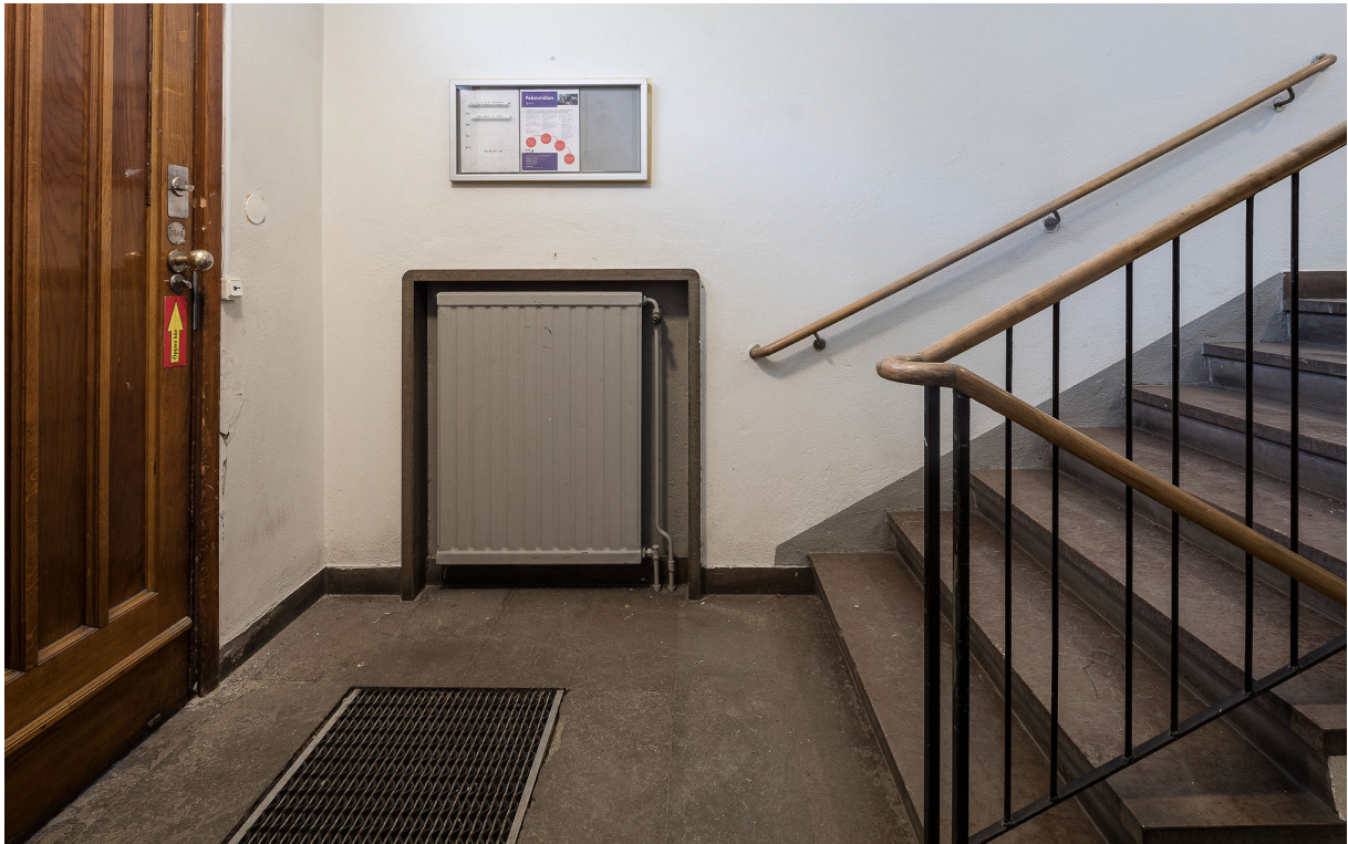
Västra högdelen trapphus med bevarad kalkstensbeläggning, smidesräcken och handledare i trä. ME SSM_I0027940
