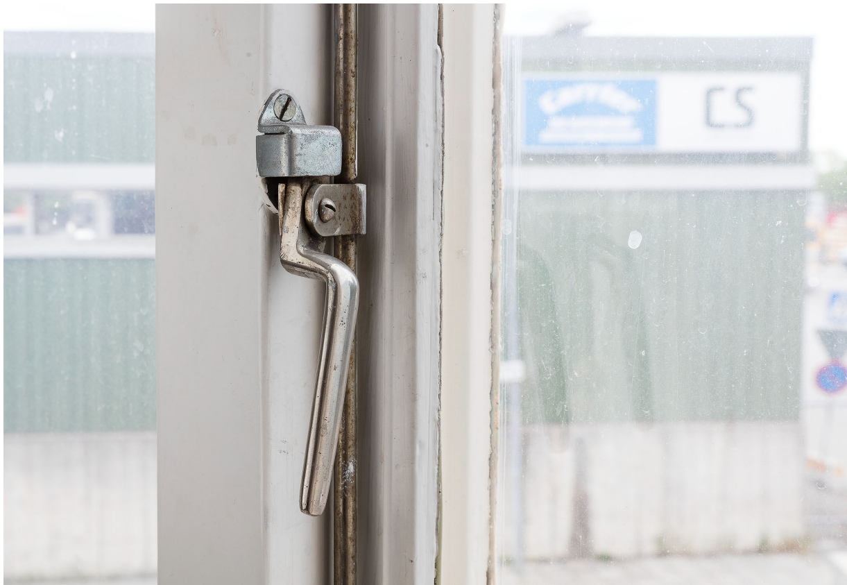
Detalj av de ursprungliga fönstren i västra högdelen med tillhörande spanjolett från 1940-talet. ME SSM_10027941
