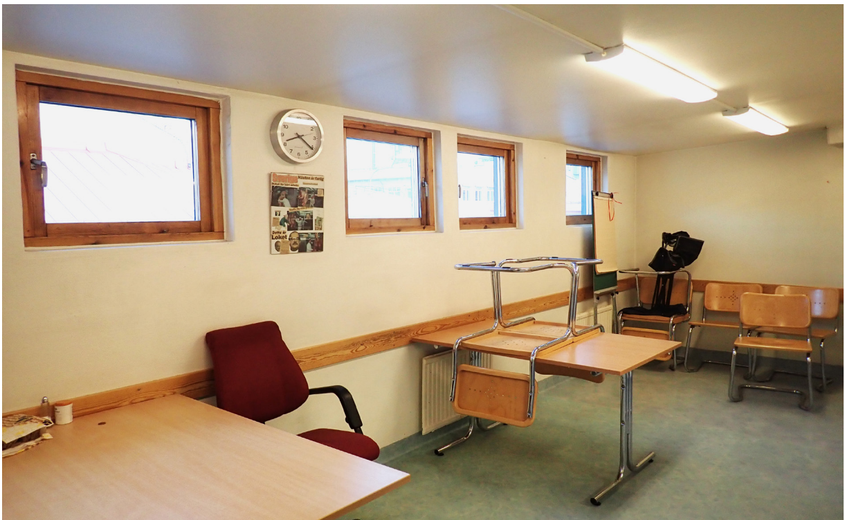
Vindsvåningens utseende med en stor andel byggnadsdelar och ytskikt från 1980-talets renovering. Exempel på detta är fönstersnickerier och bröstningslister i omålad furu liksom golvets plastmattor. Foto Sebastian Ulvsgård, SSM
