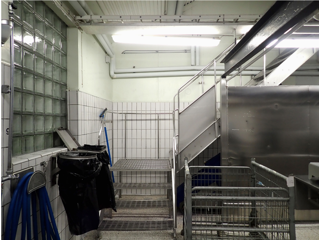
Till vänster i bild syns ett av de ljusintag i betongglas som tillkom i fasaden vid 1960-talets ombyggnad. Till höger syns trappan som förbinder personallokalerna med produktionslokalerna, helt utförd i högkvalitativt rostfritt stål. Trappan tillkom sannolikt vid 1980-talets ombyggnad. Foto Sebastian Ulvsgärd, SSM
