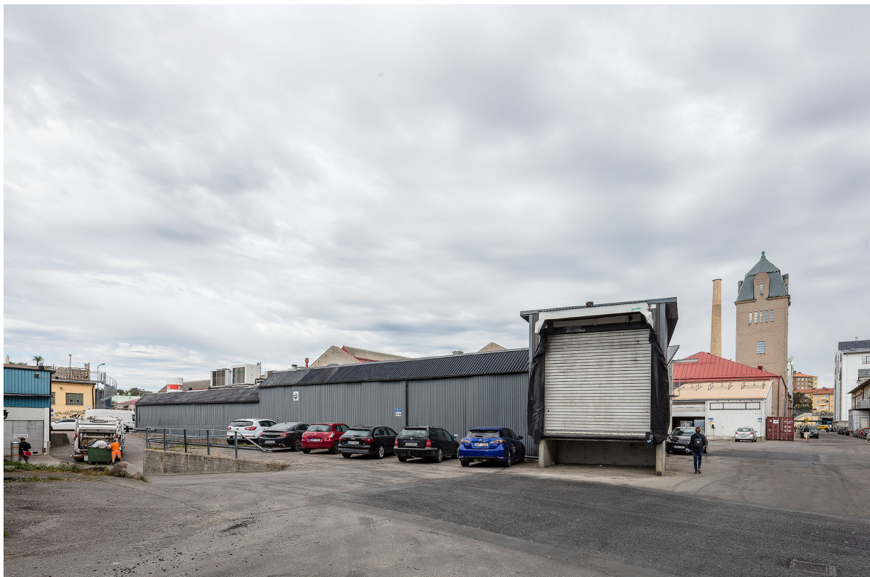
Södra tillbyggnaden, ett sentida tillskott med fasader i trapetskorrugerad plåt upptar den äldre byggnadens fulla längfasad. ME SSM_10027990
