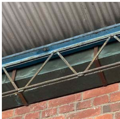
Koppardetaljer och sinuskorrugerad takplåt.
