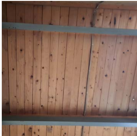
Innertag av trä på konstruktion av stål.
