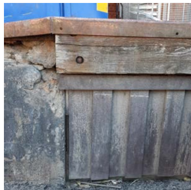
Stålskodd lastkaj.
