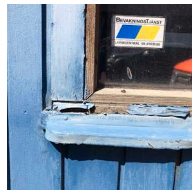
Ommålade ursprungliga fönster med nätt vattenavrinning med äldre, övermålad panel.
