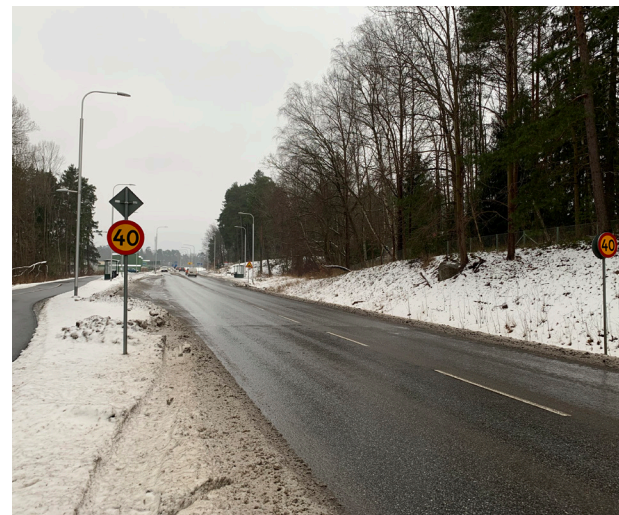
Befintliga körbanor längs Växthusvägen avskiljs med en grönremsa mot gång- och cykeltrafiken. Det finns ett körfält i vardera riktningen vilka avgränsas med målad sträckad mittlinje.
